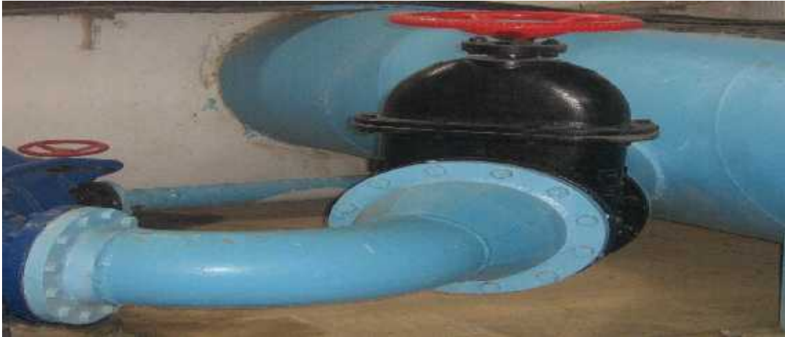
Figure V.8 : Coude, vanne à opercule et convergent
