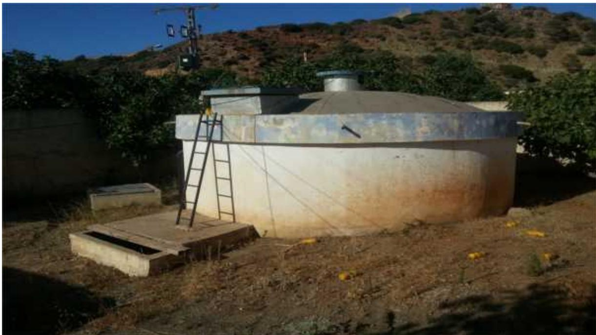
**Figure 2.2:** Le réservoir de stockage de 100 m<sup>3</sup> .
