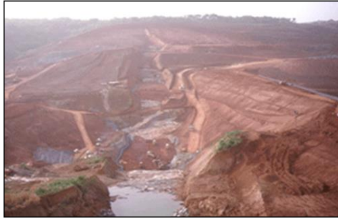
Figure 2.15- Réalisation du barrage Garafiri (Guinée) (source : planete-tp.fr)
