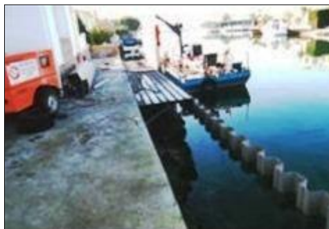
Figure 2.20- Palplanche en PVC (source : gramme.be)
