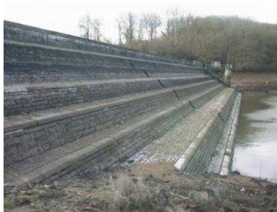
Figure 1.12- Barrage de Montaubry (source : www.barrages-cfbr.eu )
