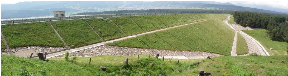
Figure 1.13- Barrage de Matemale (source : www.barrages-cfbr.eu )
