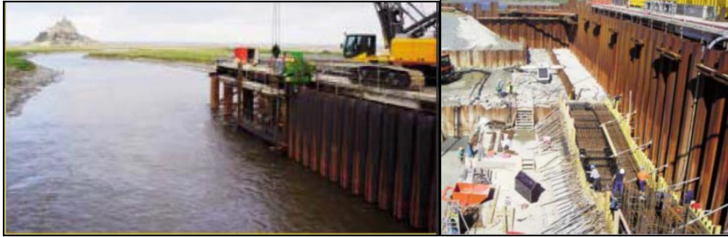
Figure 2.22- Construction d'un nouveau barrage
