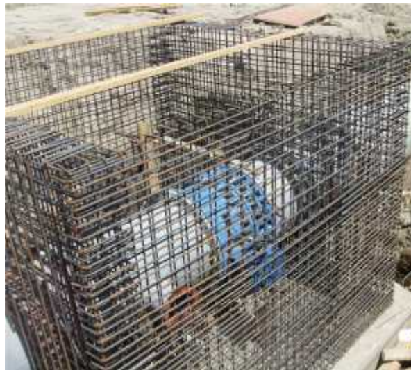
Figure VII-7 : Construction d'un regard
