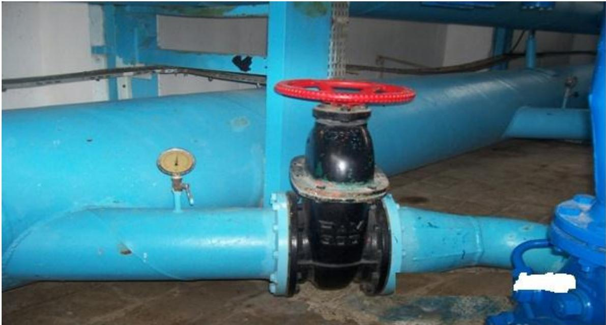
**Figure V.5 :** Vanne d’aspiration, conduites d’aspiration collective et individuelle convergent, coude et manomètre.
