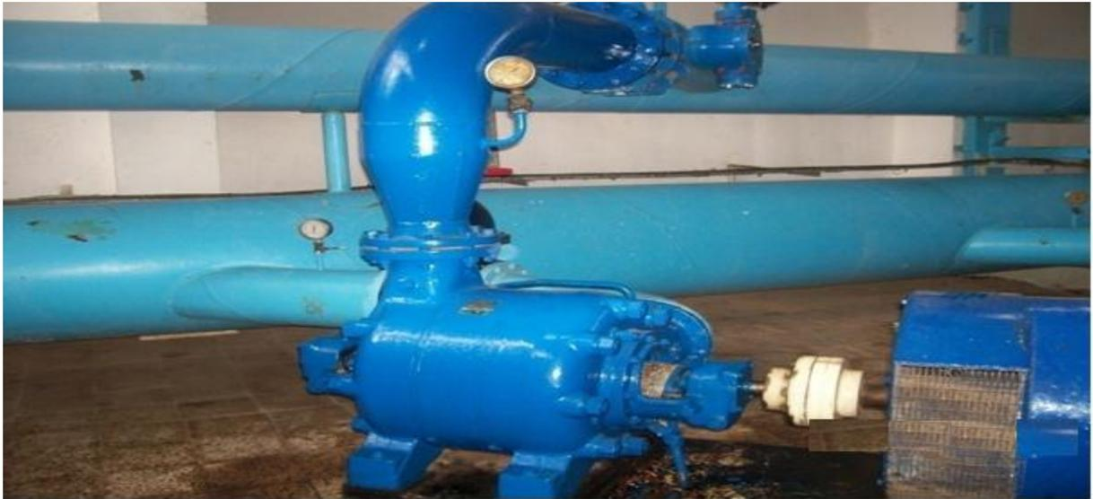
**Figure V.6 :** Pompe et moteur, divergent, coude, manomètre, conduites de refoulement individuel et collectif, clapet anti-retour.
