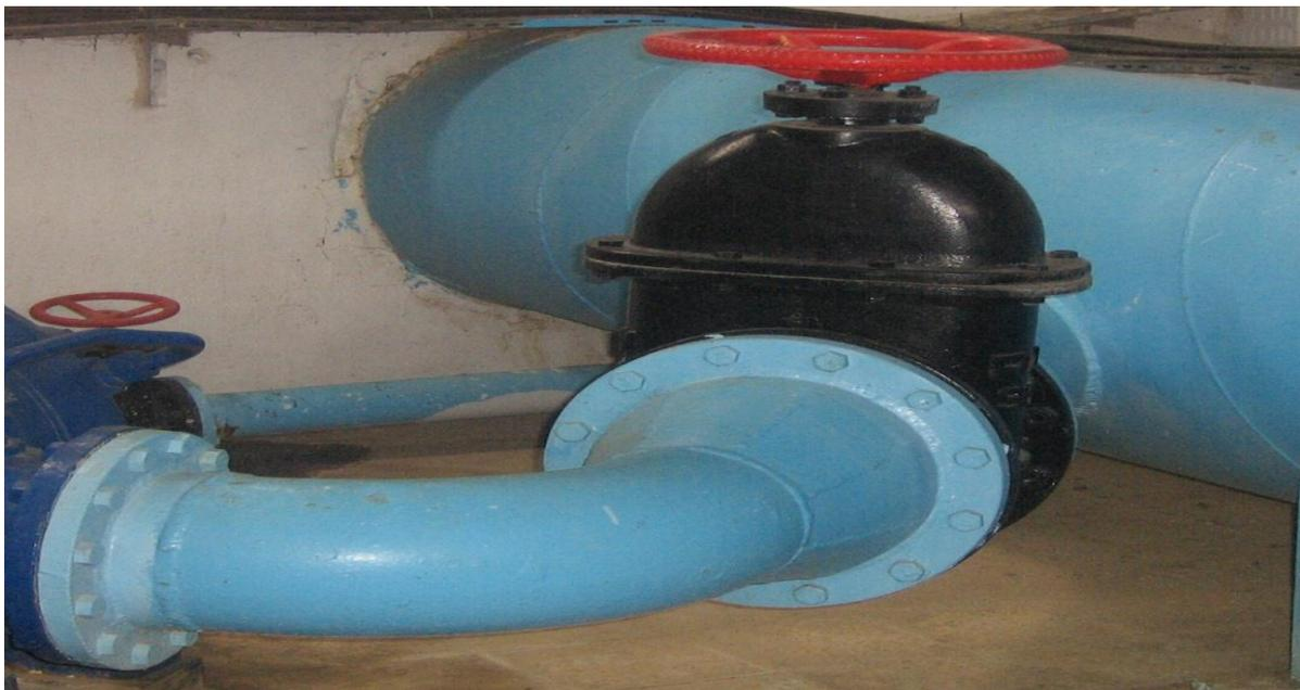
**Figure V.8 :** Coude, vanne à opercule et convergent
