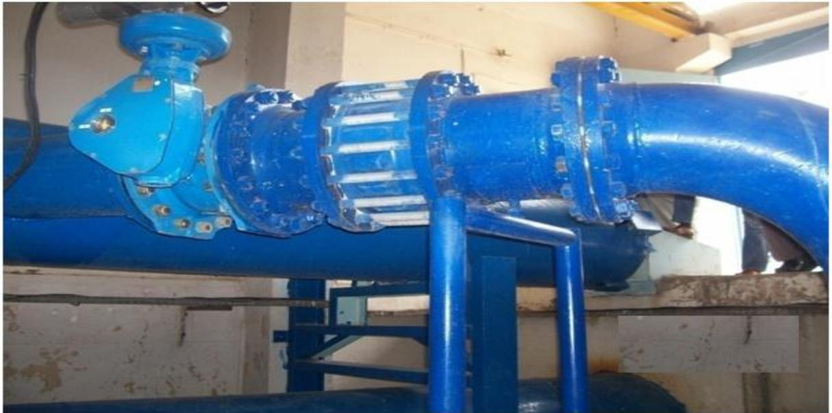
**Figure V.4 :** Joint, Coude et clapet anti-retour.
