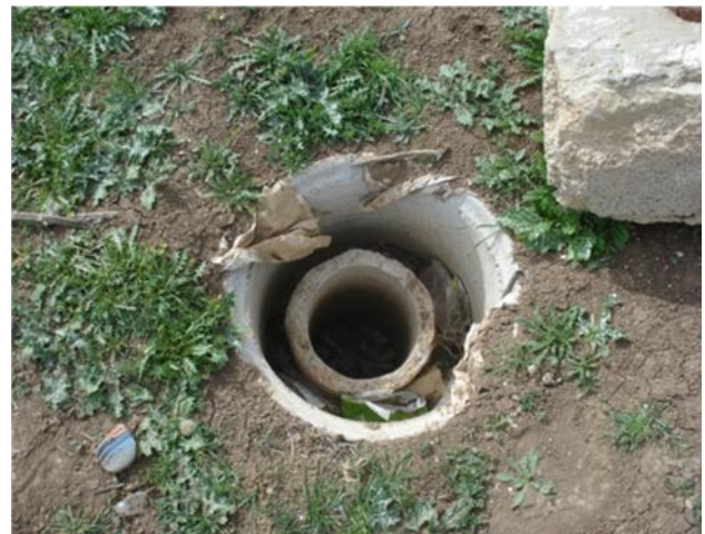
Figures I.3 : Regards des vannes du réseau d'AEP de Ain Touila
