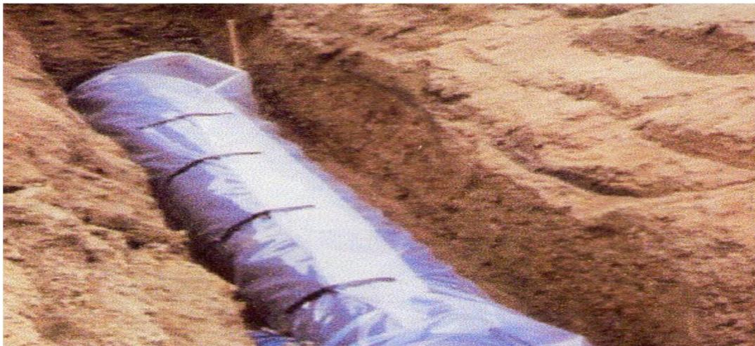
**Figure VI.2:** Installations de tuyaux recouverts d'une protection en polyéthylène
