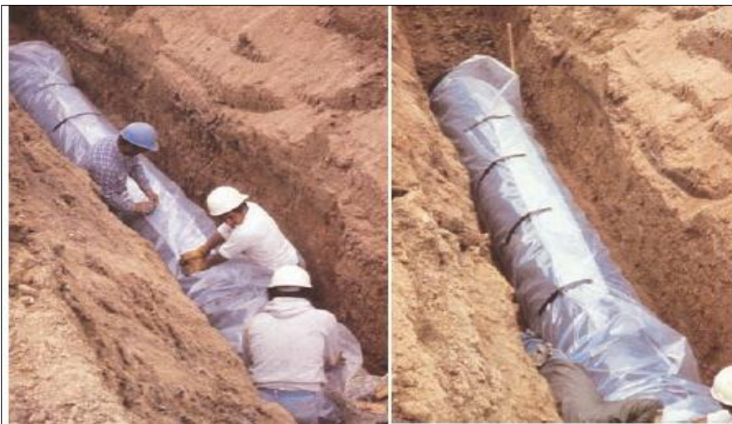
Figure VI.7 : Protection contre la corrosion extérieure avec revêtement en polyéthylène
