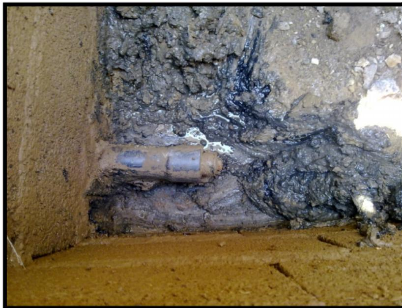
**Figure II.4 : Bouchon en PVC plein de boue qui provoque des MTH**
