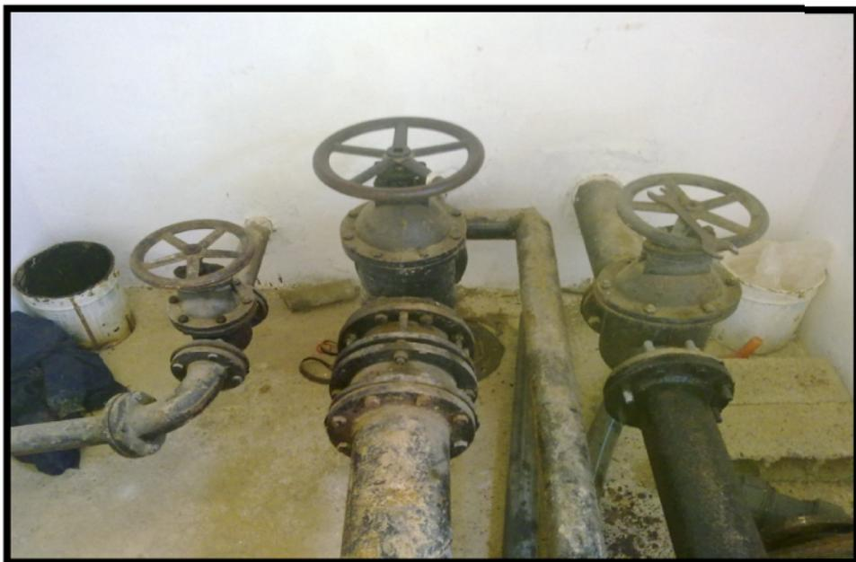
**Figure V.2 : Chambre des vannes réservoir 500m<sup>3</sup>**
