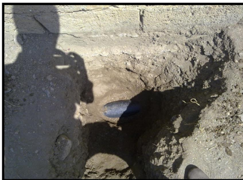
**Figure II.2 : conduite de distribution en PVC passe sous la clôture d'une maison**
