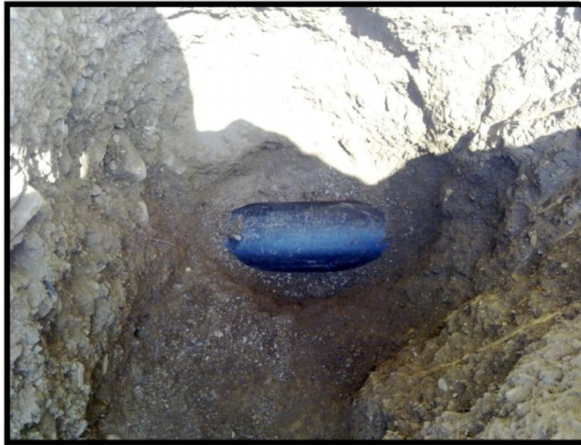
**Figure II.3 : Conduite de distribution en PVC**
