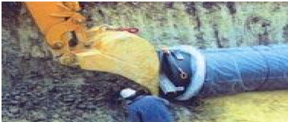
Figure VI.7: Pose de conduites dans un terrain agressif.
