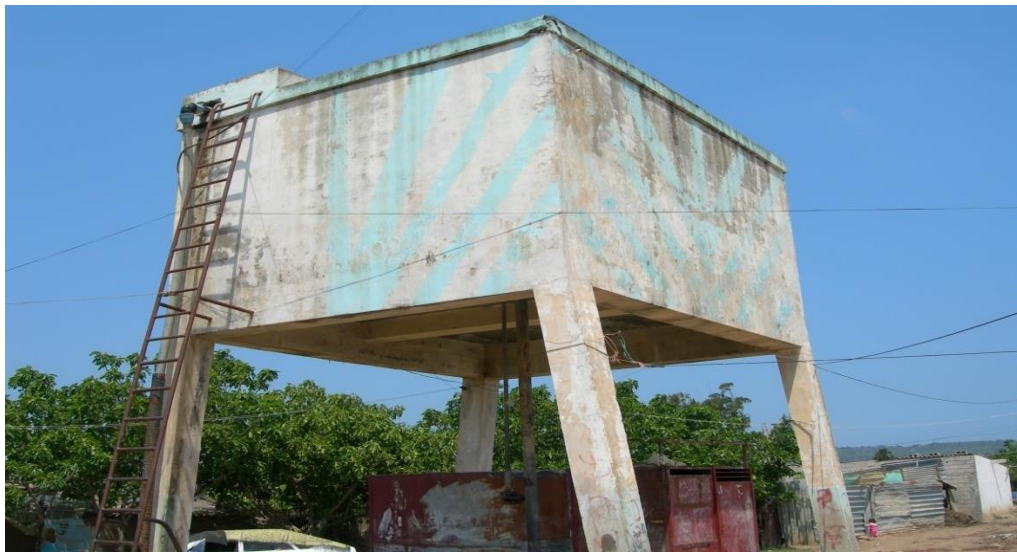
Figure II-13: Réservoir surélevée 75 m 3 (douar 40 logements).
