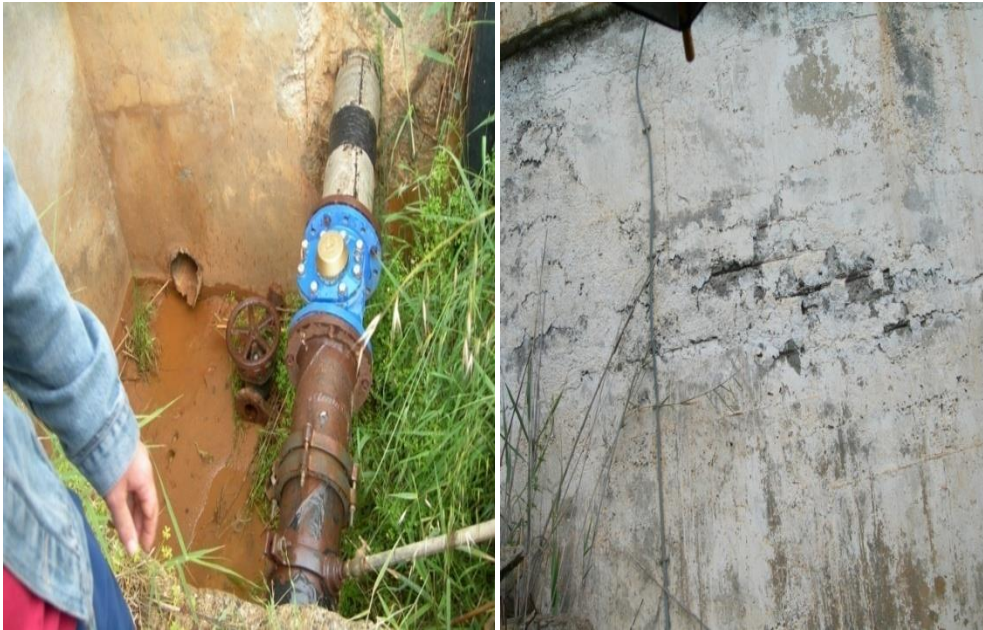
Figure II-9 : Réservoir de 1000 m 3
