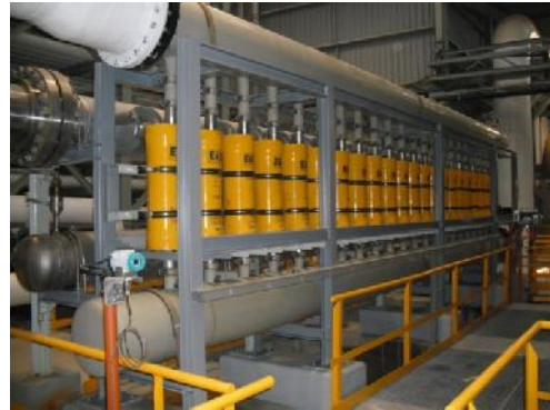
Figure IV-9: Système de récupération d'énergie(ERI) [19]
