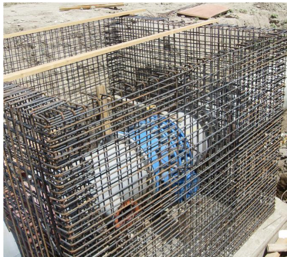
Figure V.7 : Construction d'un regard
