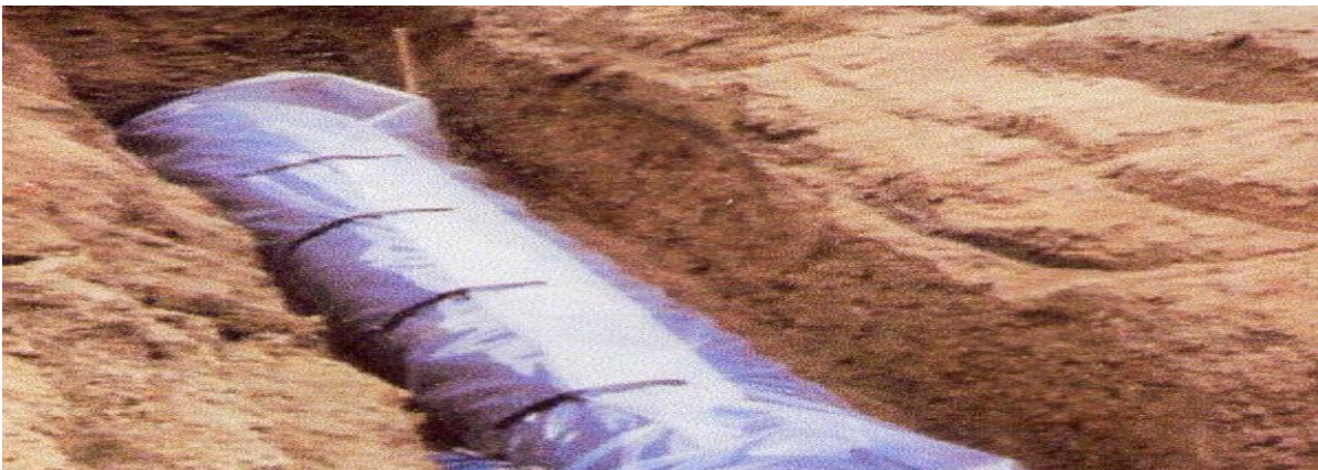
Figure V.12 : Installations de tuyaux recouverts d'une protection en polyéthylène.
