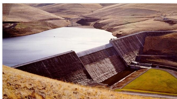
Figure I.8 : Vue du parement aval gauche du barrage BCR de Willow Creek
