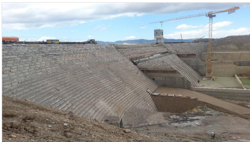
Figure I.9 : Construction d'un barrage en béton compacté aux rouleaux
