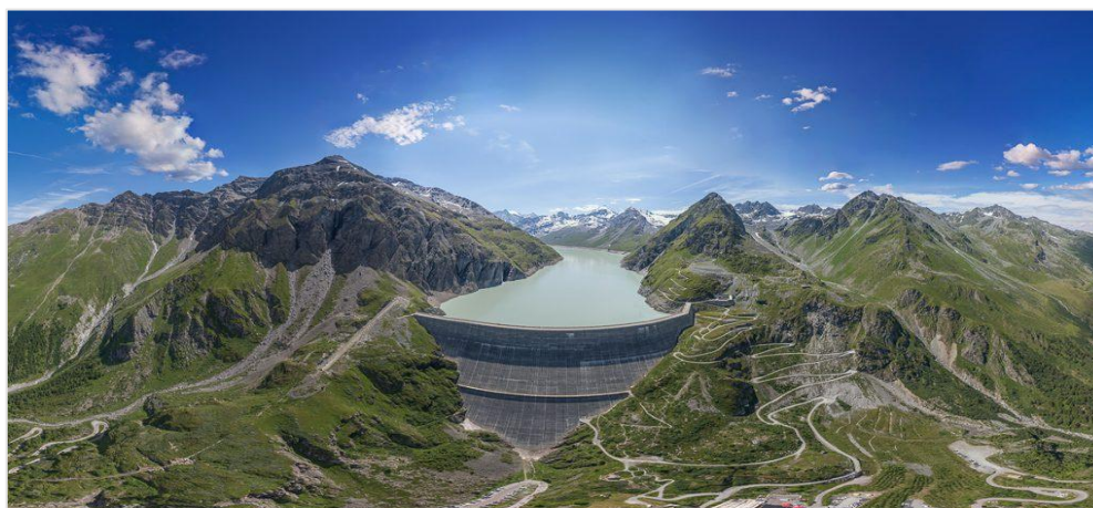
Figure I.3 : Barrage poids de la Grande Dixence (Suisse)
