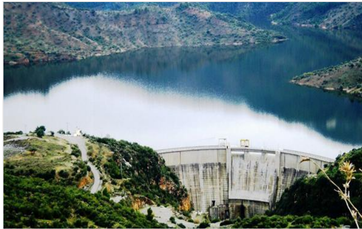
Figure II.3 : Vue aval du barrage de Tichy Haf
