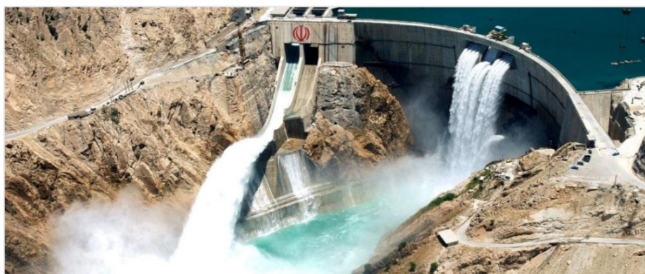
Figure I.6 : Vue de l'aval du barrage voûte de Karun III en Iran
