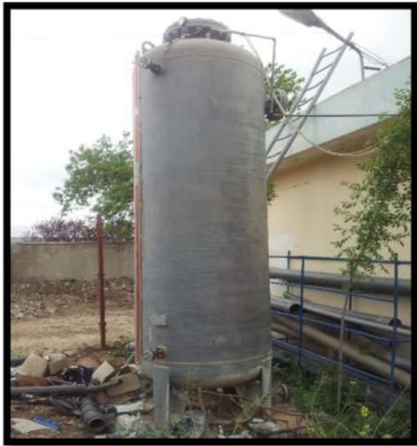
Figure-II-14. Réservoir Anti coup de bélier de la station de pompage 3.
