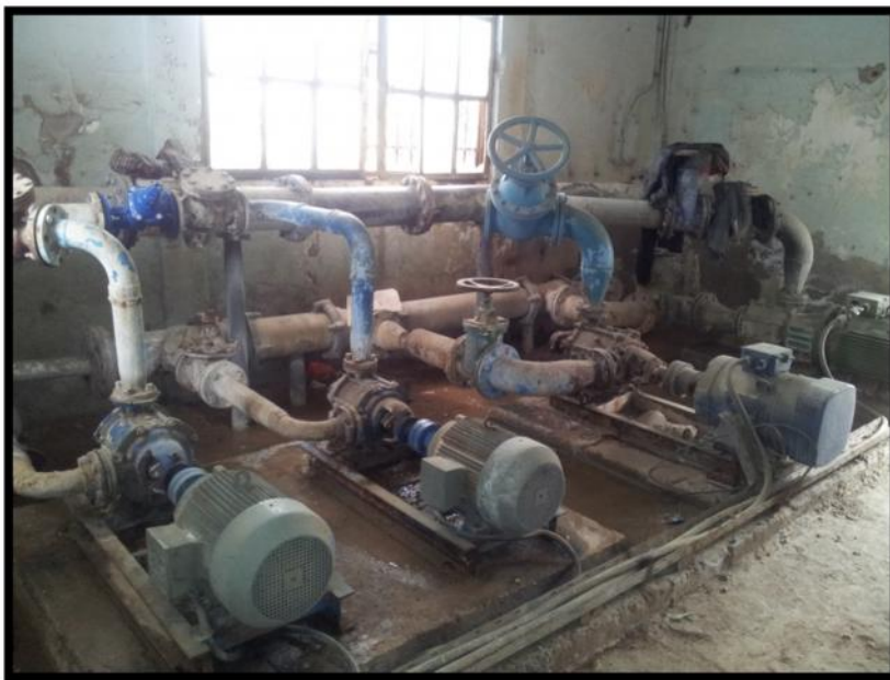
Figure-II-2. Etat de la Station de pompage 1.
