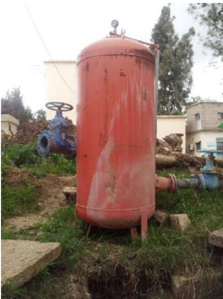
Figure-II-5.Réservoir anti bélier de la Station de pompage 1.
