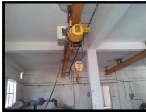
Figure-II-13.Les ponts roulants de la station de pompage 3.
