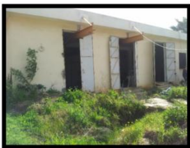
Figure-II-9.Etat extérieur de la Station de pompage 3.
