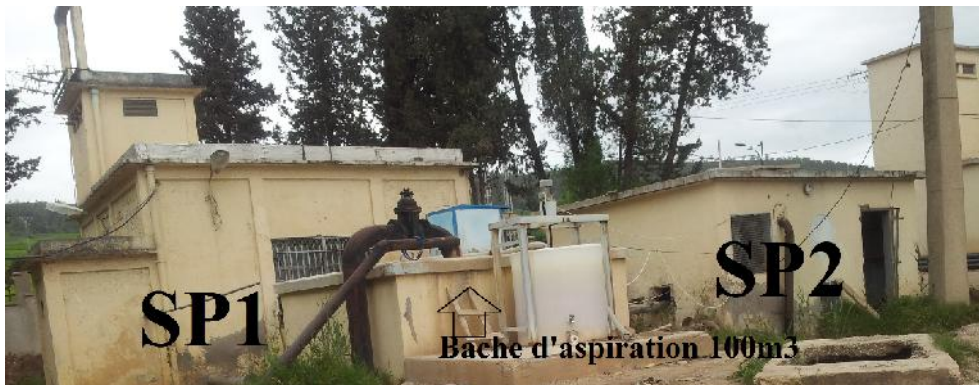
Figure-II-1.Etat extérieur de la Station de pompage 1 et la station de pompage 2.
