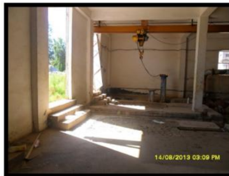
Figure-II-8.Etat intérieur de la Station de pompage 3
