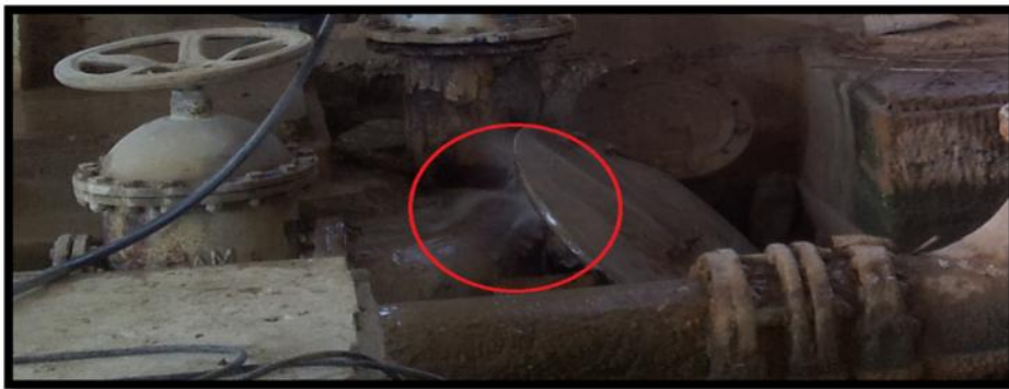
Figure-II-11. Etat intérieur de la Station de pompage 1.
