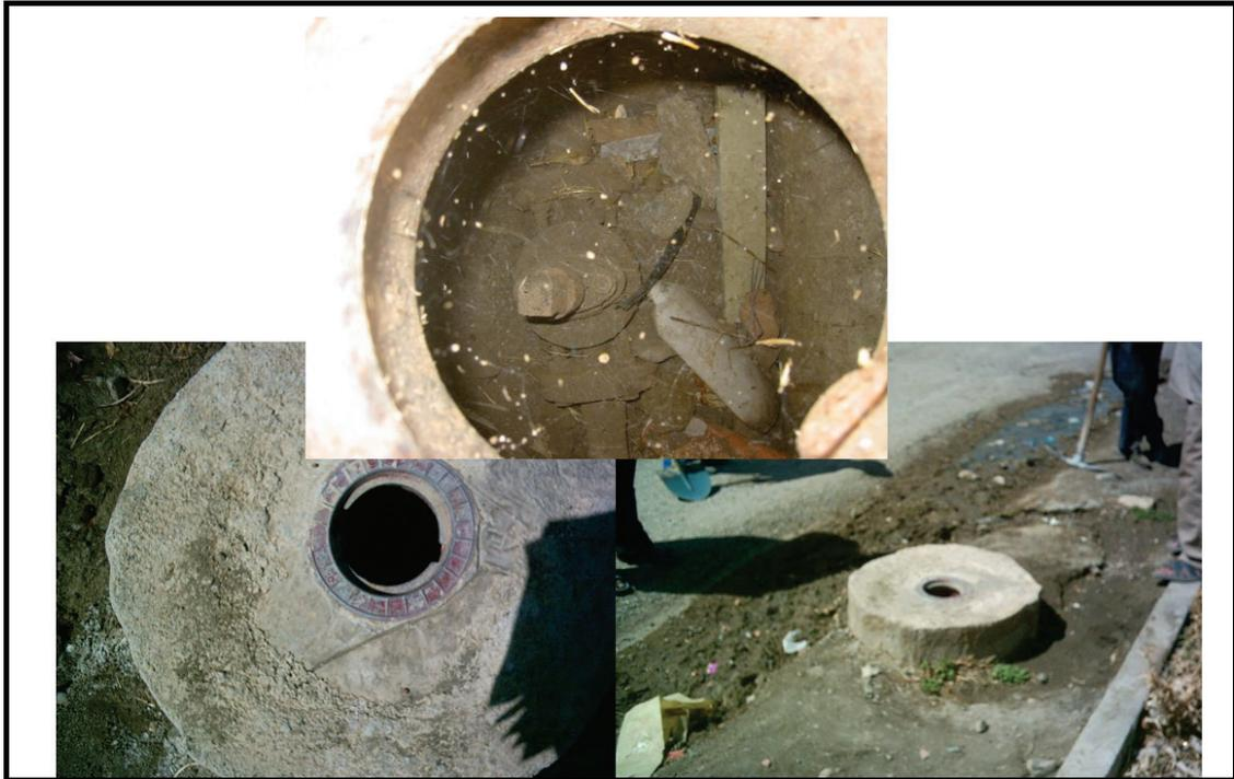
**Figure III.2 :** Regards de robinetterie d’AEP qui sont en mauvais état
