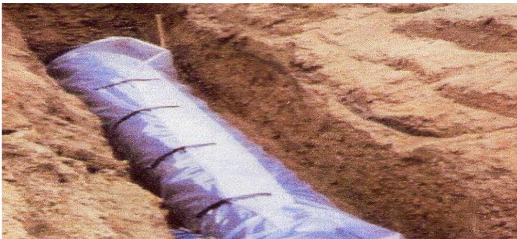
Figure VI.3: Installations de tuyaux recouverts d'une protection en polyéthylène
