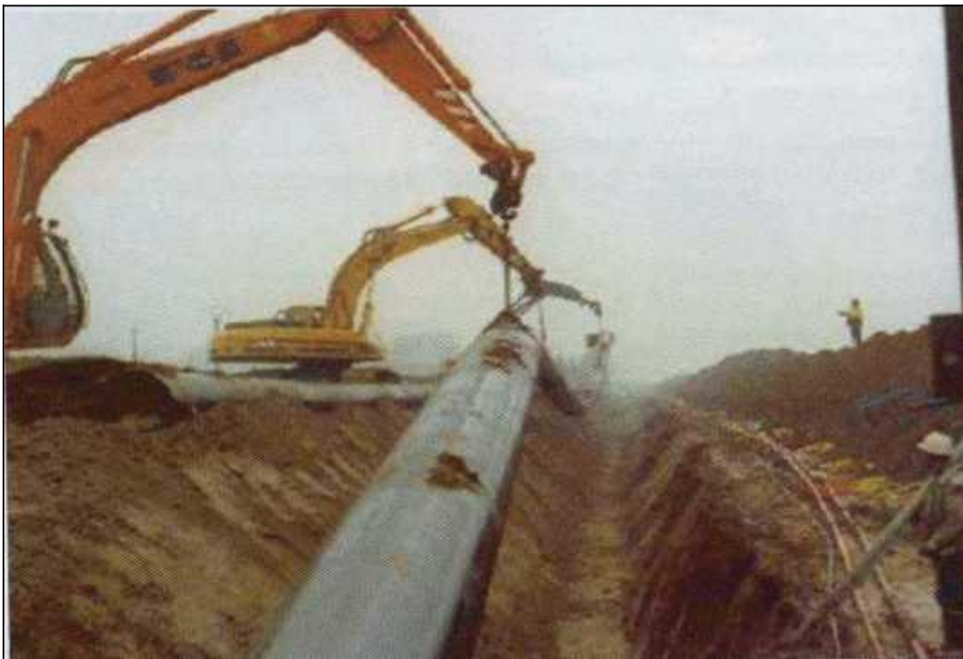
Figure VII.1 : Pose des conduites en PEHD dans les tranchées.
