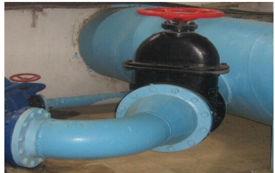
Figure V-15 : Coude, vanne à opercule et convergent
