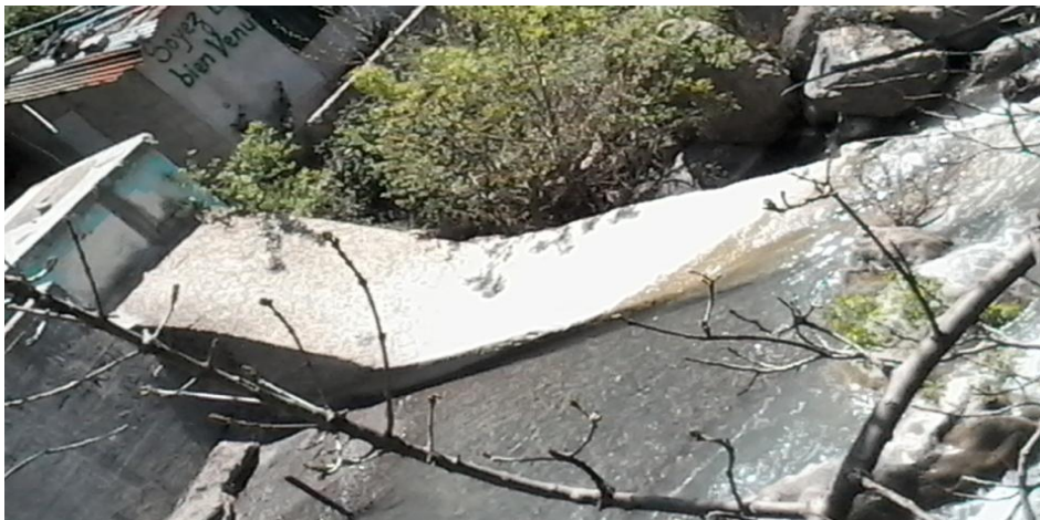
Figure I-10 : Canal d'acheminement d'eau de la chambre du captage vers le réservoir de stockage (2015).
