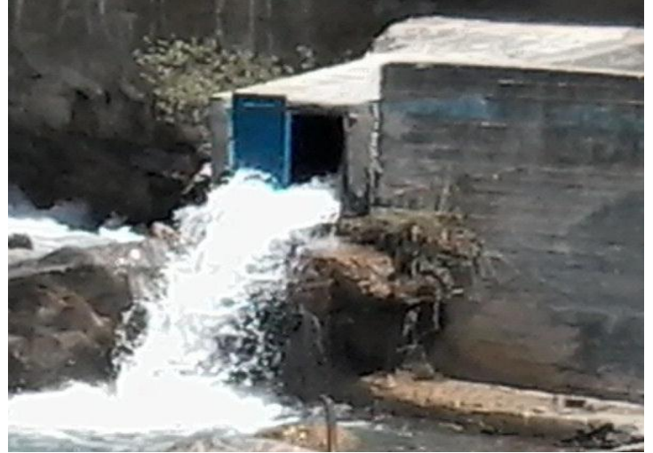
Figure I-9: Evacuateur de surplus de débit capté (trop plein) (2015).
