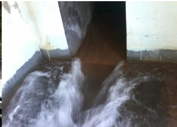
Figure I-13: Brise charge capture (photo prise de l'intérieure) (2015).
