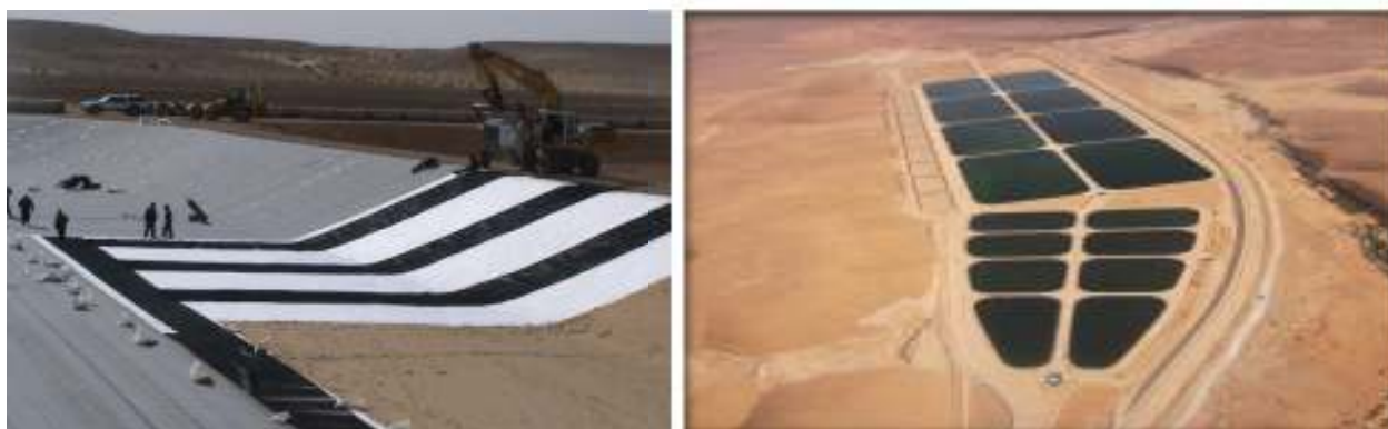
Figure IV. 25 : Vue aérienne de la STEP d'El-Atteuf (DRE ; 2012)
