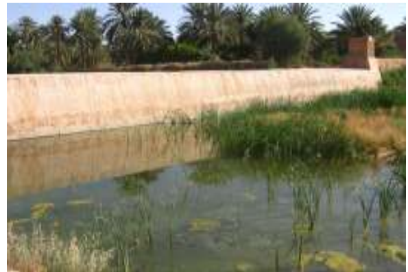
Remontée de la nappe (ANRH 2010)
