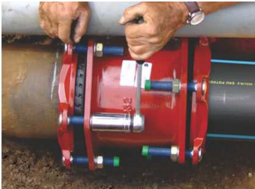
Figure VII.9 : Assemblage par joint Gibault
