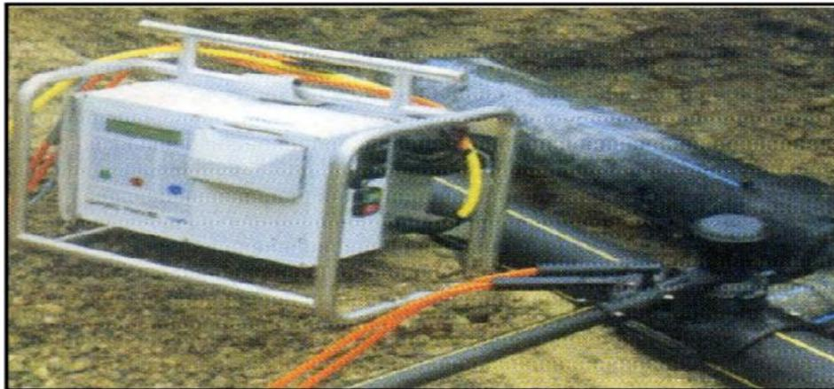
**Figure VII.2:** Raccordement par accessoires électro-soudables
