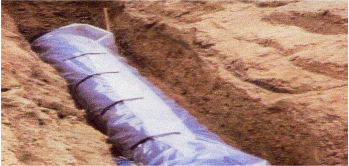
Figure VI-6 : Installations de tuyaux recouverts d'une protection en polyéthylène
