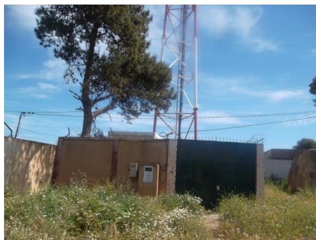
Figure 29 : Photo du pylône téléphonique OOREDOO
