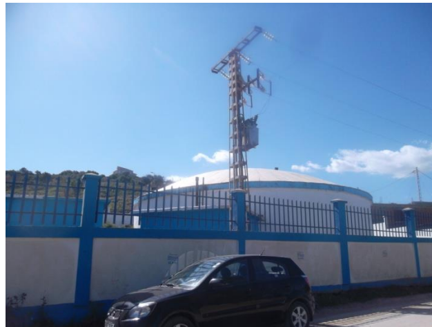
Figure 18 : Photo du réservoir Ouest Cherchell
