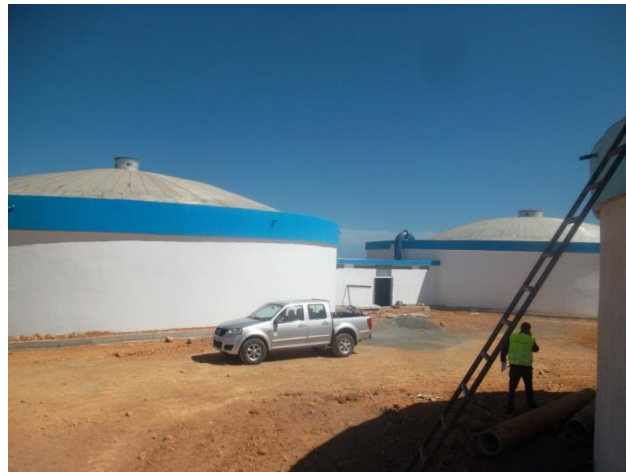
Figure 20 : Photo des deux réservoirs hors service (6000+3000m 3 )
