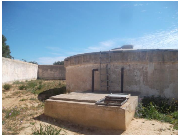
Figure 17 : Photo du réservoir Sidi Cherif
