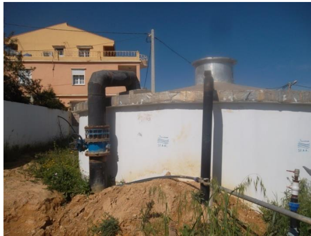
Figure 16 : Photo du réservoir Sidi M'Hamed Lamghit
