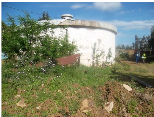
Figure 21 : Photo du réservoir Oued El Bellah
