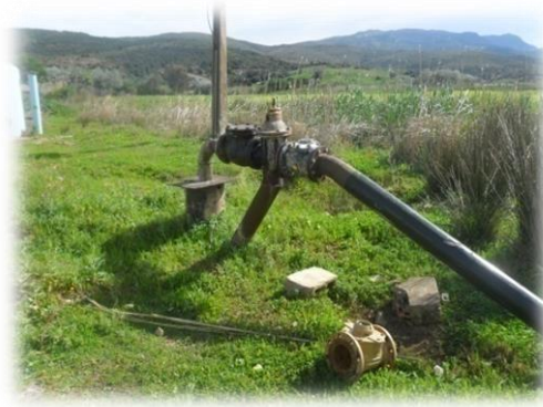
Figure 1 : Photo du forage F1
