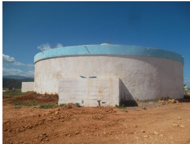
Figure 19 : Photo du réservoir Tampon Sidi Yahia 1000m 3
