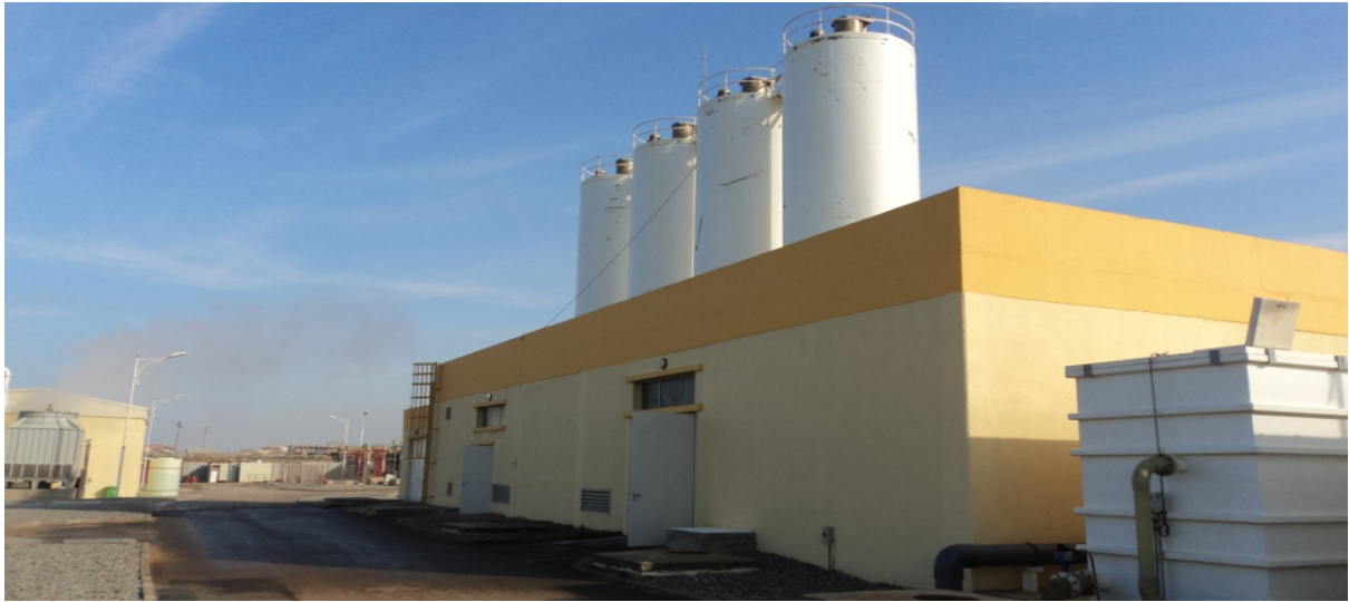
Figure IV.11 : Silos de la chaux. (Propre Photo)
