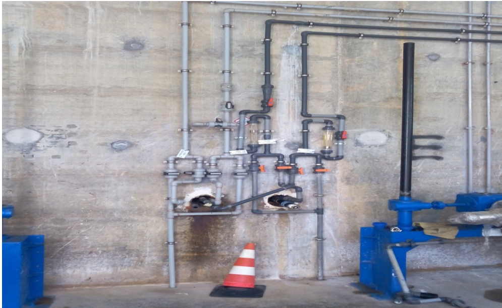
Figure IV.06 : Les prises des produits chimiques. (Propre Photo)
