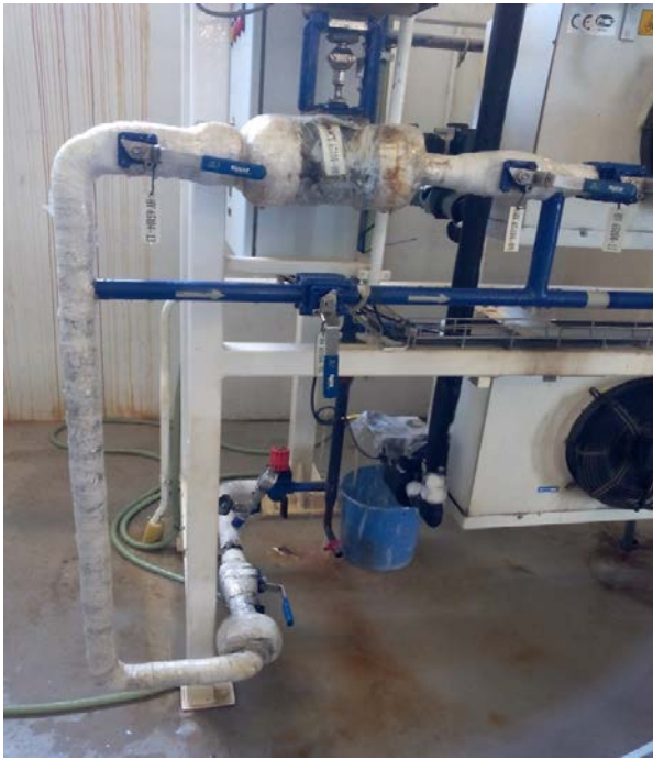
Figure V.02 : La congélation des tuyaux [Propre Photo]
