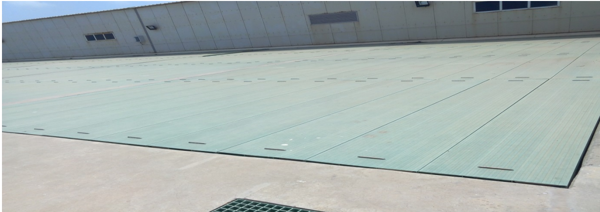
Figure IV.07 : Les filtres gravitaires. (Propre Photo)
