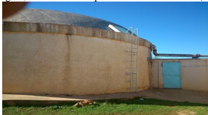
Figure 2.4 : Réservoir Route A /Kermès.
