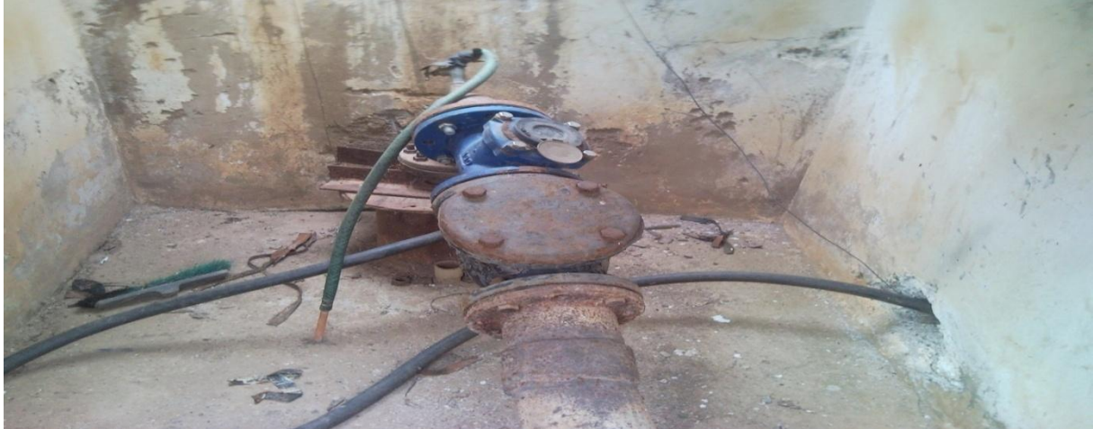
Figure 3.5 : Forage d'oued ferdja.
