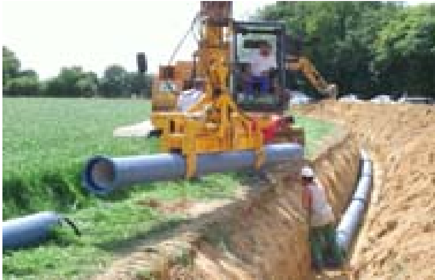
Figure VII.1: Pose de conduite dans un terrain ordinaire.
