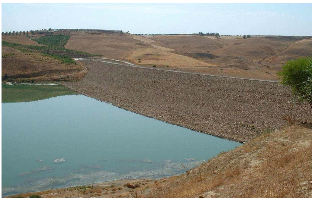
Figure I.6 : Vue de la digue du barrage de Sidi Abdelli
