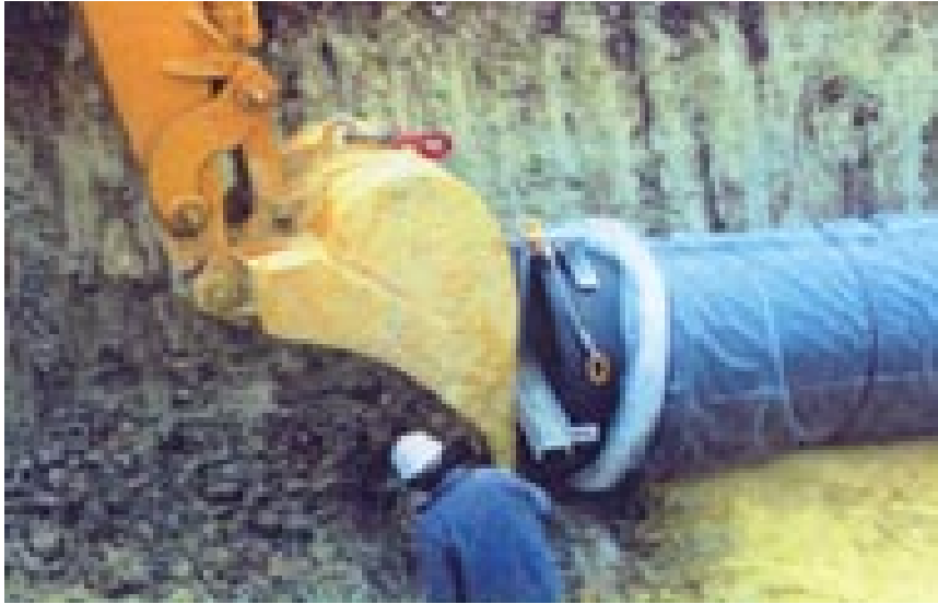
Figure VII.3: Pose de conduites dans un terrain agressif.
