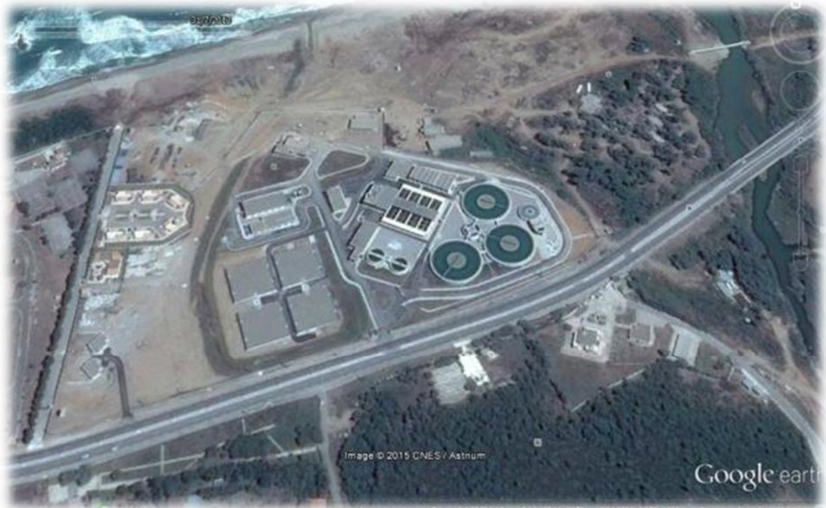
Figure I.9 : Vu aérienne de la station de traitement de KISSIR
