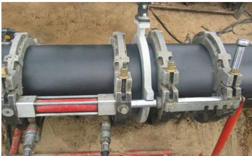
Fig 5.3 : Soudage bout à bout PEHD
