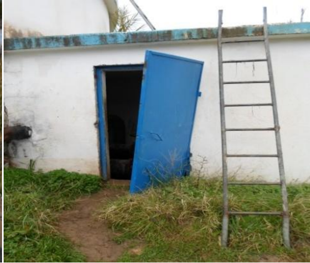
Fig 3.10 : Porte d'accès a la chambre des vannes
