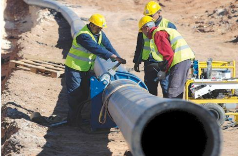
Fig 5.2 : Electrosoudage des tubes en PEHD
