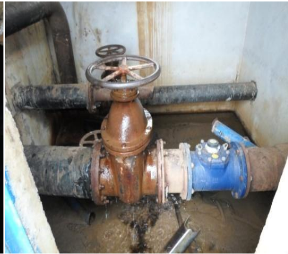
Fig 3.12 : Vanne de distribution
