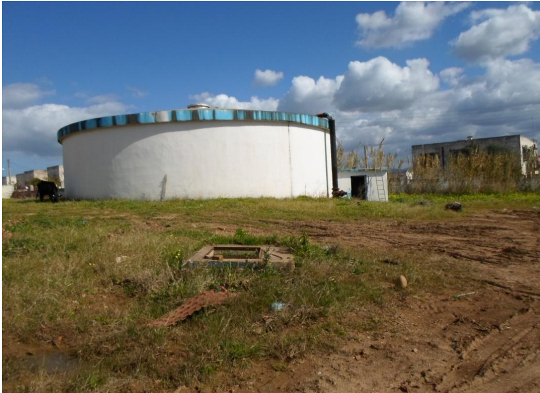
Fig 3.8 : Vue extérieure du réservoir semi-enterré de Dréan
