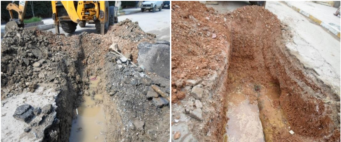
Fig 3.22, 3.23 : Travaux de réparation de fuites
