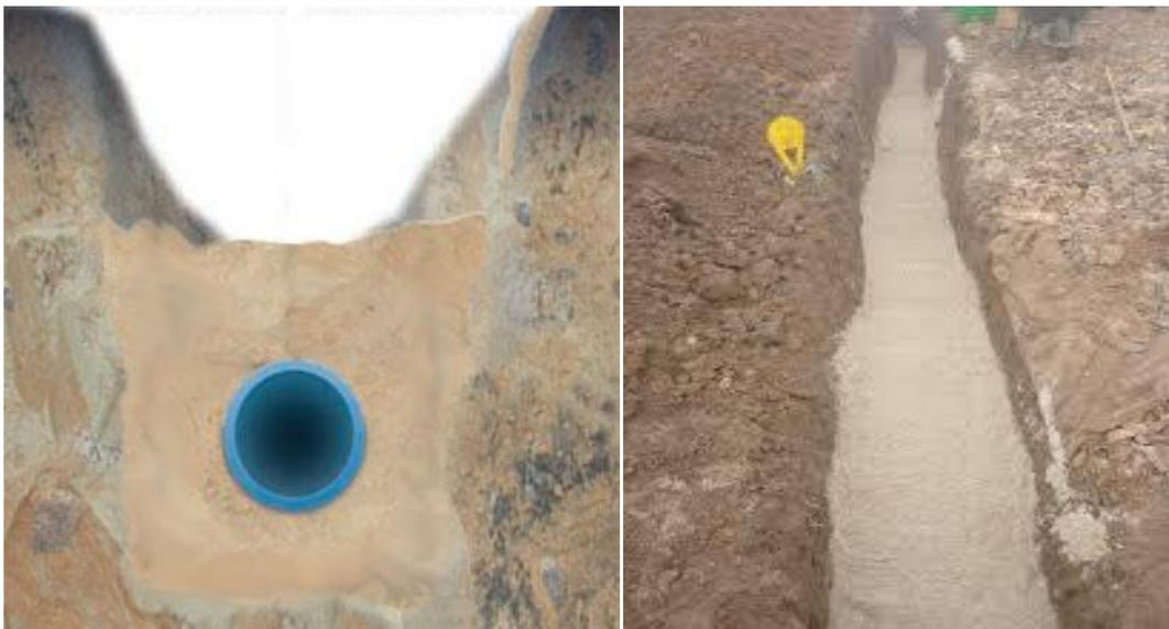
*Figure VII.2 : la pose de lit de sable et les conduites*
