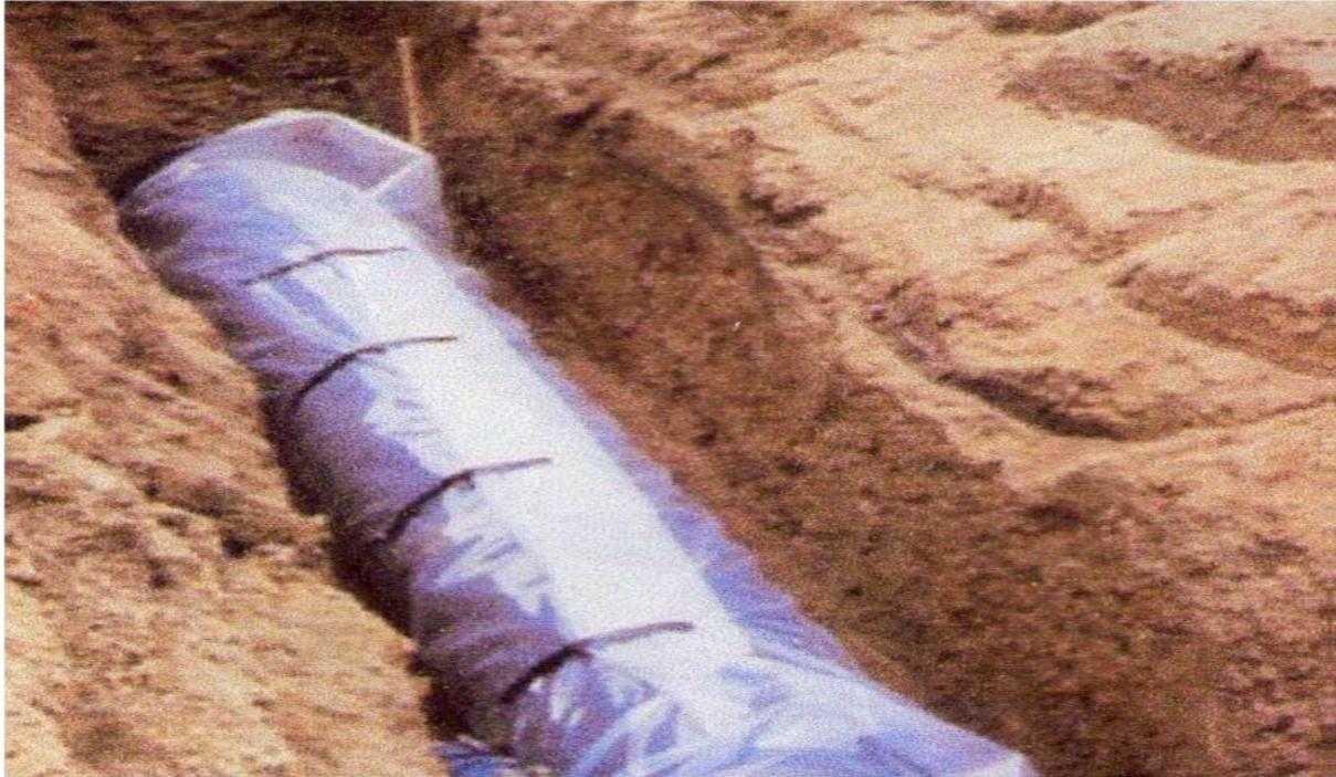
**Figure VIII.1.** Installations de tuyaux recouverts d'une protection en polyéthylène
