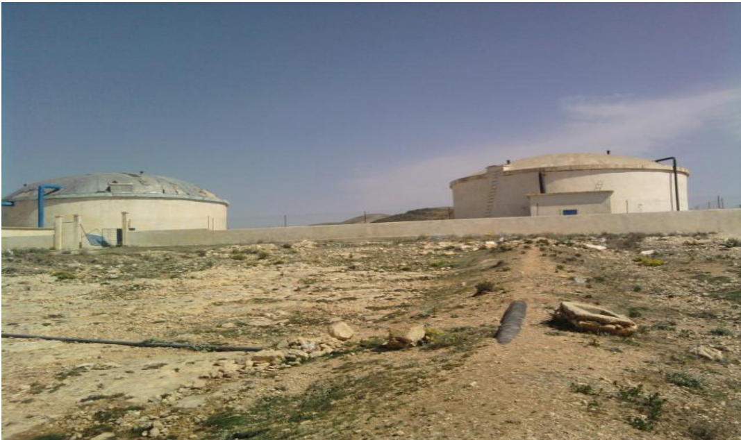
Figure III.4 : Réservoir 2X2500m 3 de la zone industriel
