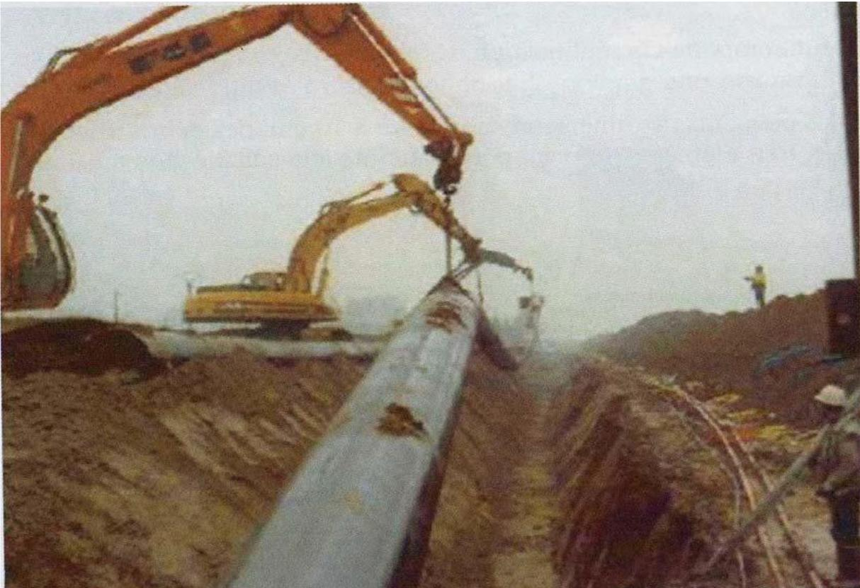
**Figure VI.2 : pose des conduites en PE dans les tranchées**
