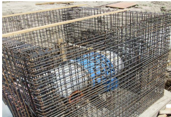
Figure 5.9: Construction d'un regard
