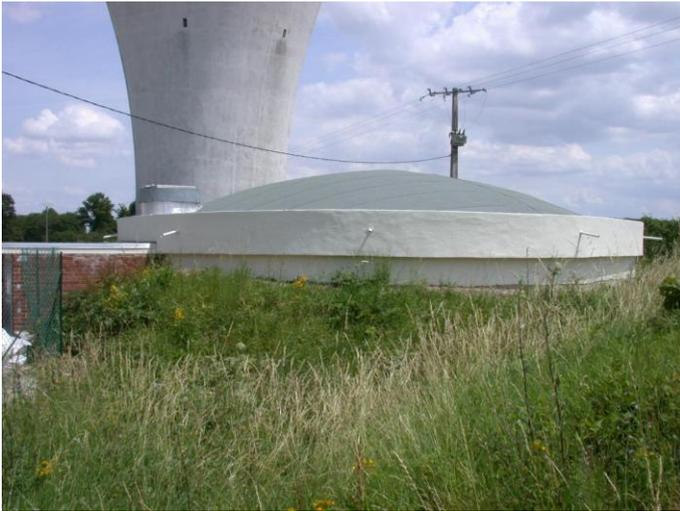
Réservoir a cuve cylindrique semi enterrée
