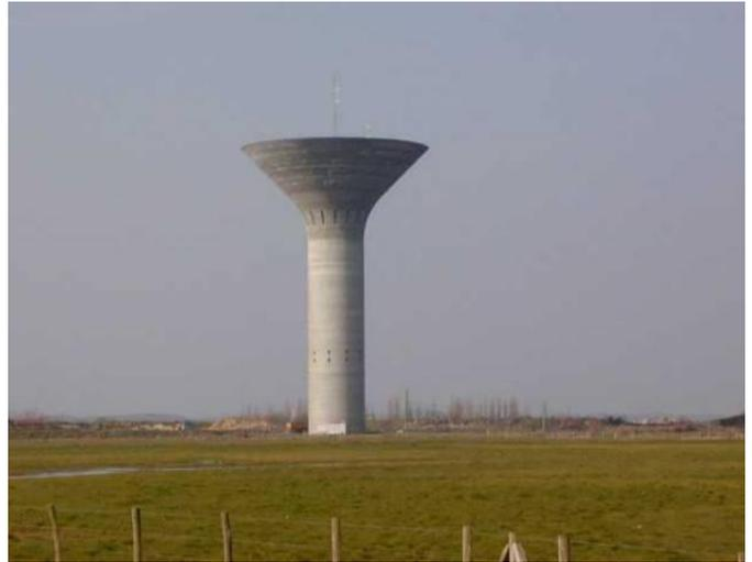
Réservoir surélevée à cuve conique
