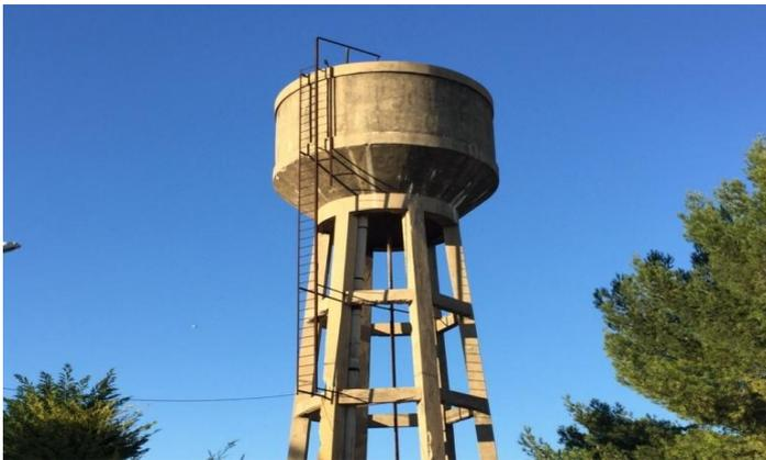
Réservoir surélevée à cuve cylindro-conique
