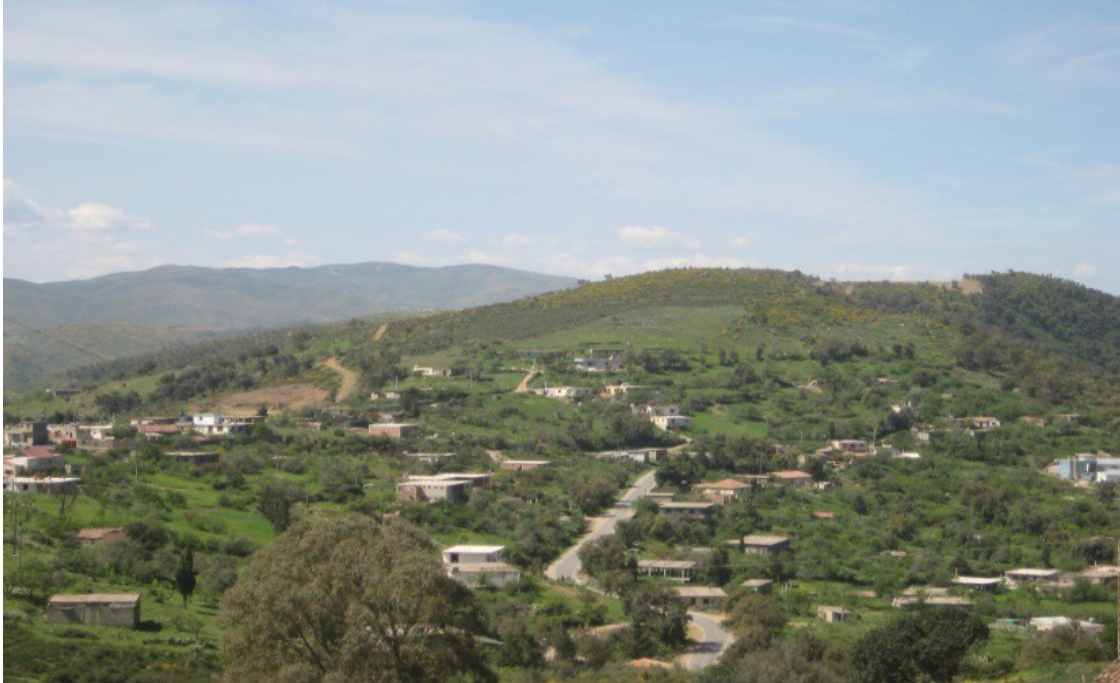
Figure IV.6 : L'emplacement du réservoir de stockage
