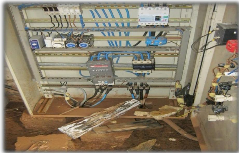
**Figure IV.4 :** Etat de l'armoire électrique.
