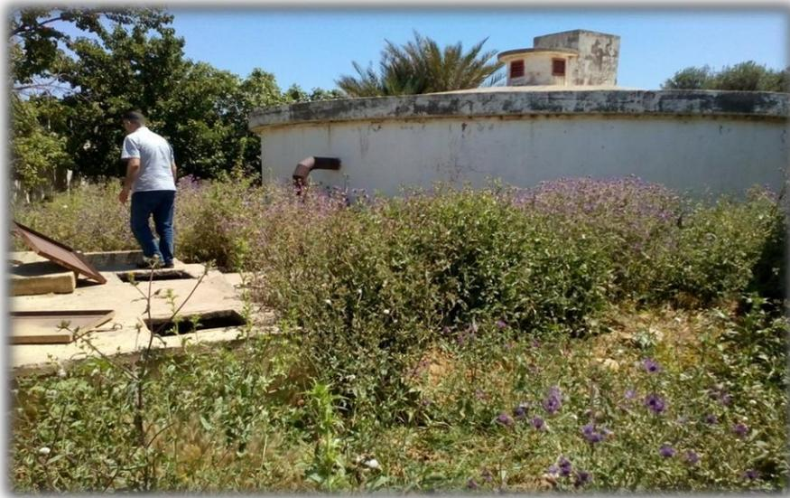
**Figure III.4 :** Etat de l'espace entourant les réservoirs.
