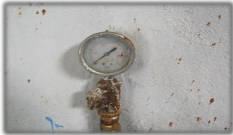
**Figure IV.1 :** Manomètre en arrêt a l'intérieur du forage F2.
