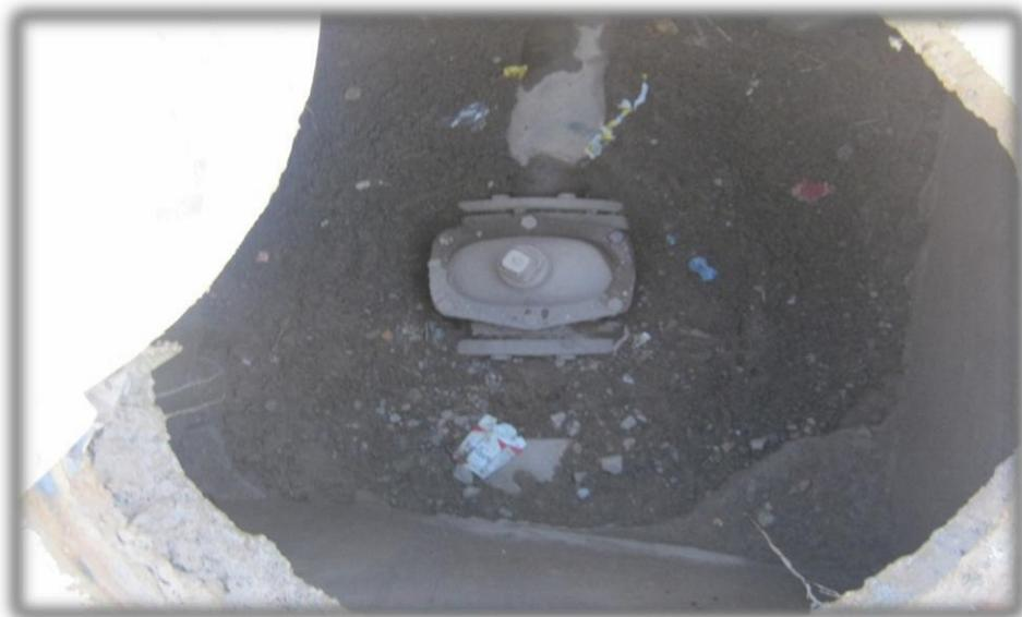
**Figure IV.13 :** Regard de vanne nécessite un nettoyage.
