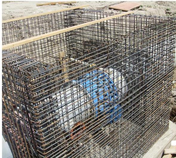
**Figure V-7 :** Construction d'un regard
