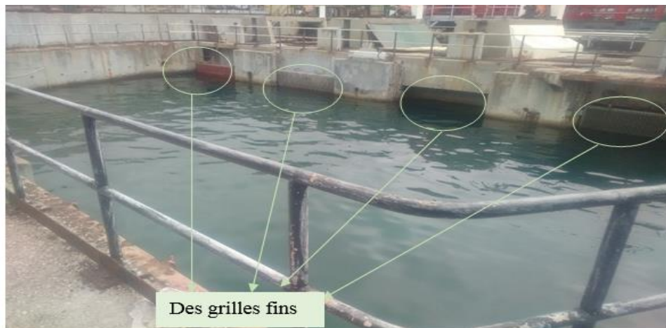
Figures IV.07 : Les grilles fines. [Propre Photo]
