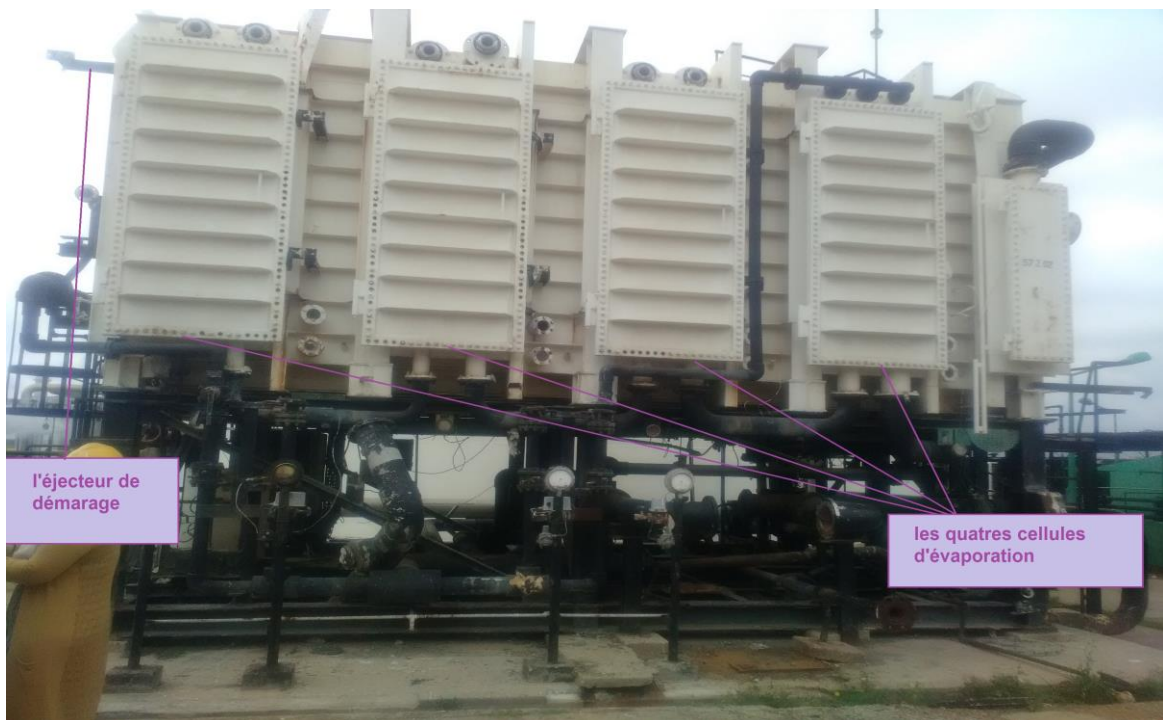
Figure .IV.10. Une unité de dessalement [4T 1440 A]. [Propre Photo]
