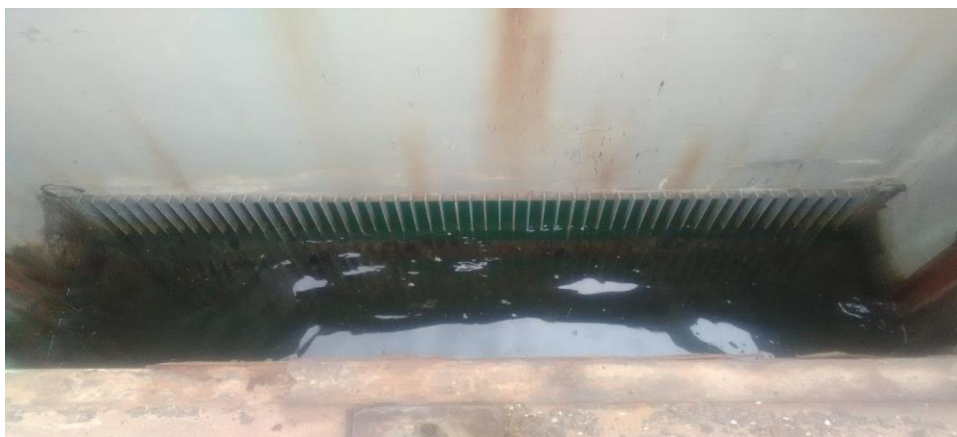
Figure IV.06 : Grille grossière. [Propre Photo]
