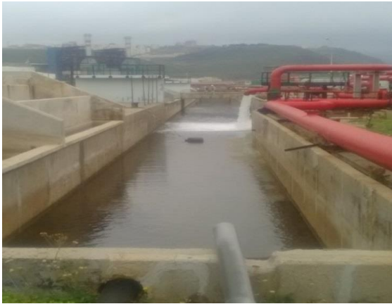
Figure V.20 : Le canal d'évacuation des rejets de la station. [Propre photo]
