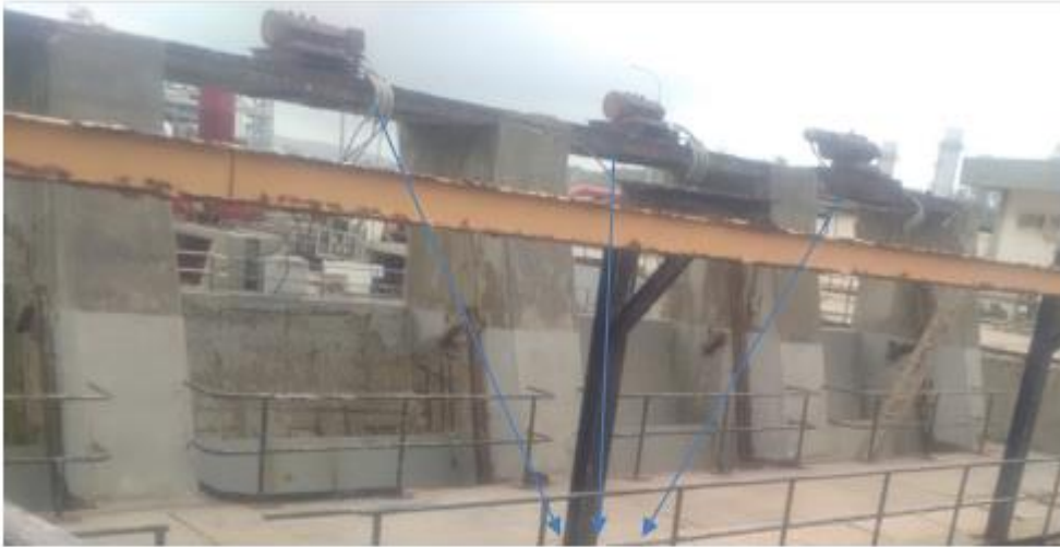
Figure V.01 : Les racleurs hors service (état actuel). [Propre photo]
