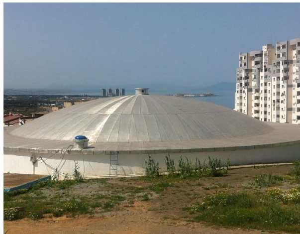
Figure II.10 : Réservoir de distribution (H.DJIDI.2016)
