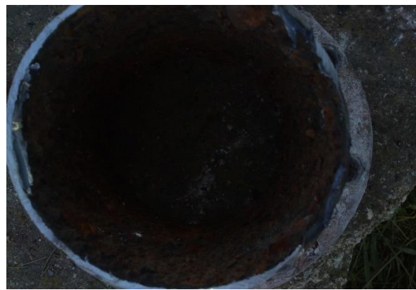
Figure II.1 : Etat des conduites en FTI (SEAAL.2013)
