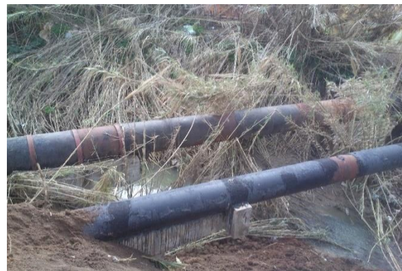
Figure II.2 : Etat des conduites en Acier ( H.DJIDI.2016)
