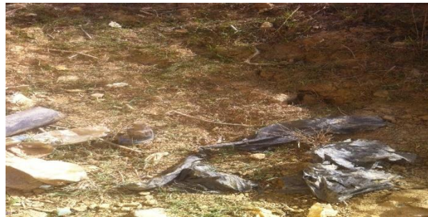
Figure II.3 : Etat des vannes (SEAAL.2015)
