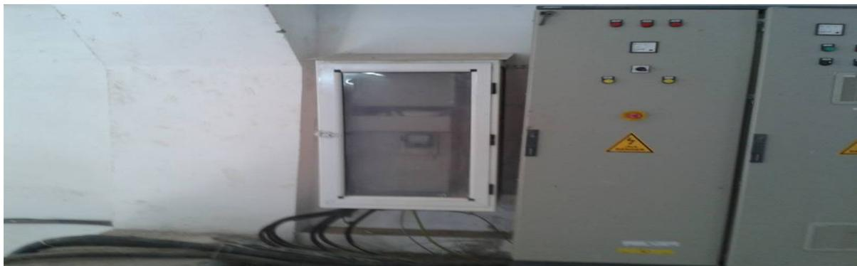
**Figure V.42:** Câbles électriques sans protection
