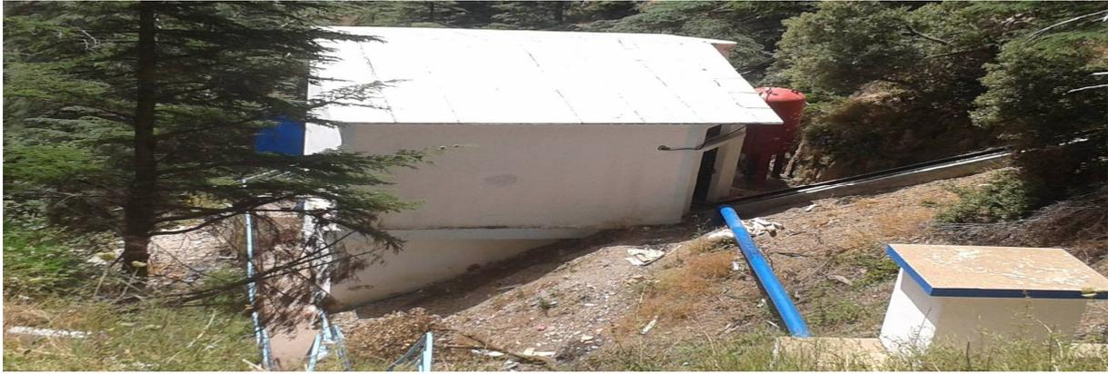
**Figure V.31:** L'anti bélier est placé à l'extérieur du bâtiment
