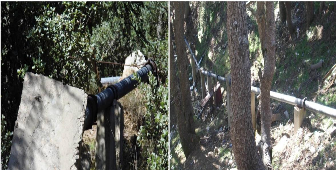
**Figure IV.1 :** Etat des socles et de la conduite de refoulement
