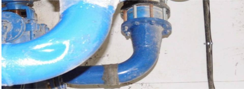
**Figure V.9:** Etat des conduites de refoulement à l'intérieur de la station après application de peinture sur les parties corrodées
