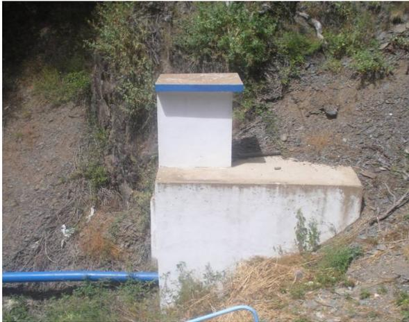
**Figure V.2 :** photo illustré d'ouvrage de captage
