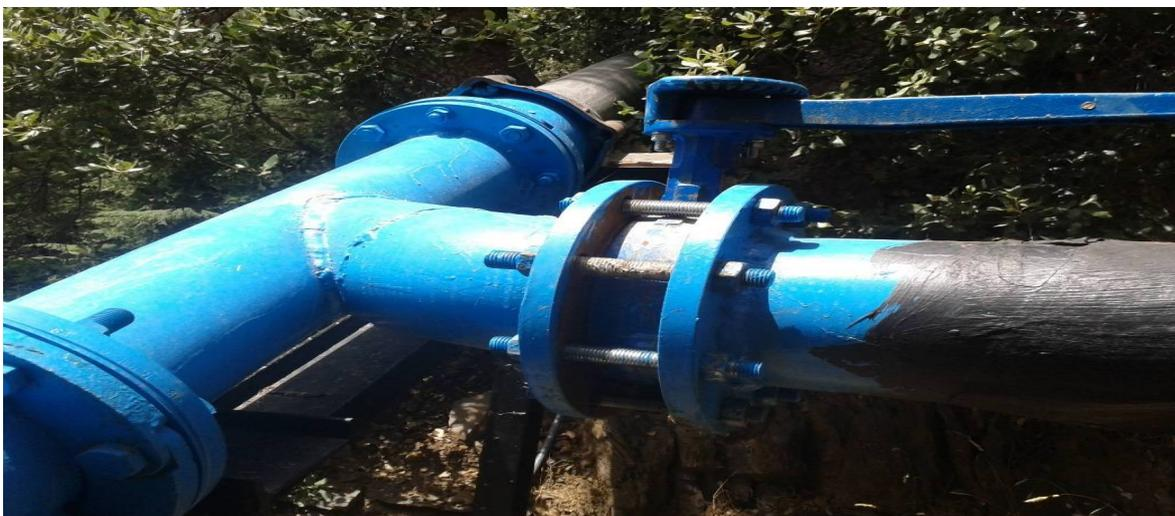
**Figure V.33 :** Raccordement de l'anti bélier a la canalisation de refoulement
