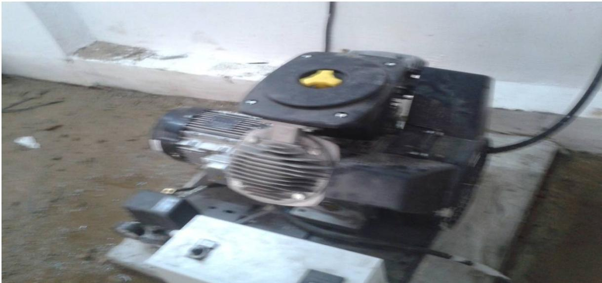
**Figure V.32 :** Compresseur pour l'alimentation de l'anti bélier
