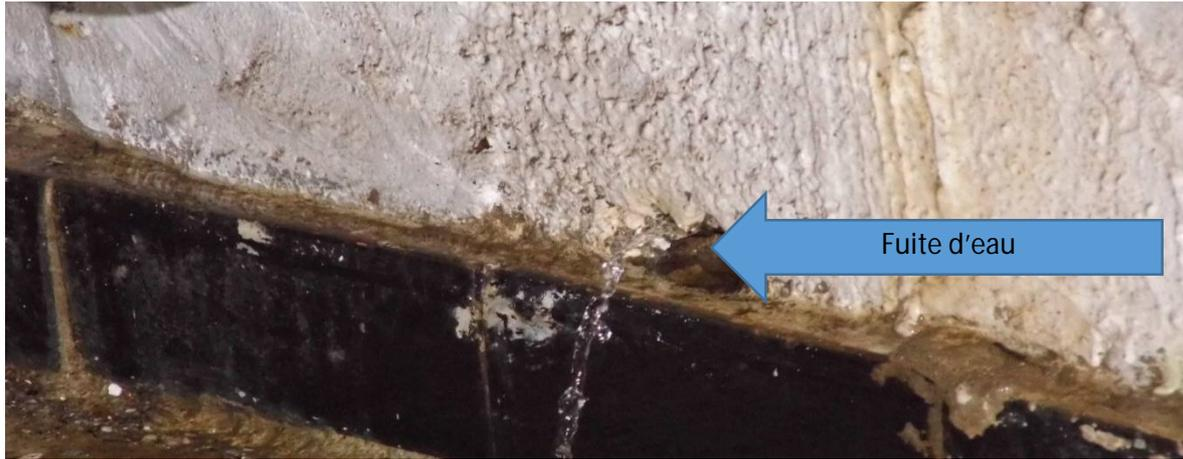
**Figure V.38:** Etat de la bâché d'eau fuite a l'intérieur de la station.
