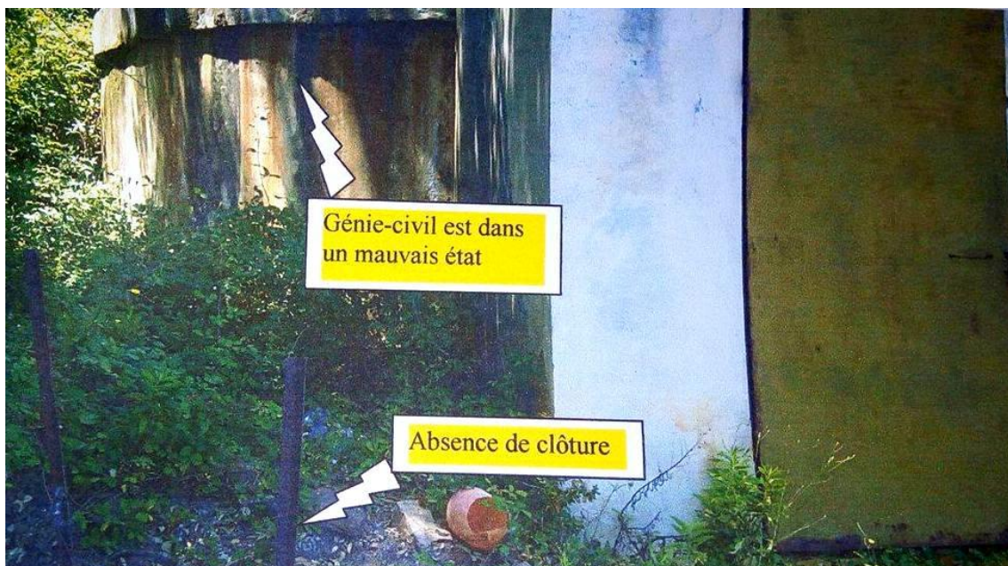
Figure (III.08): Réservoir El Maaden
