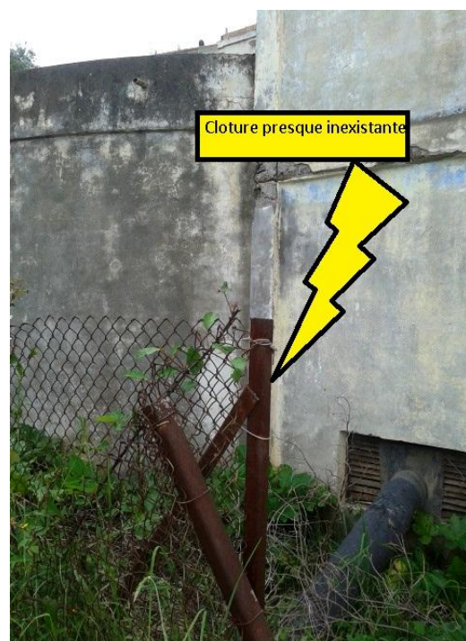
Figure (III.6): Vue de l'extérieur de la station de reprise d'Imechattane.
