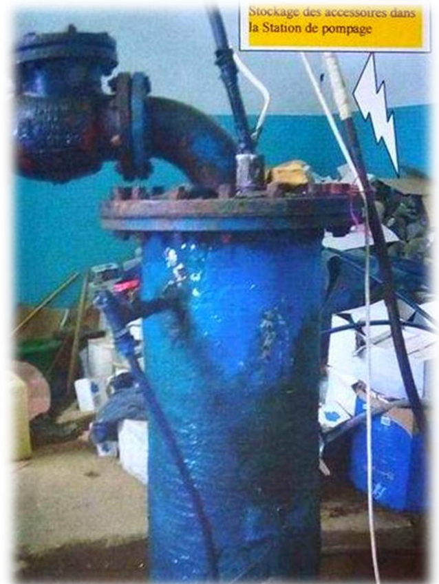
Figure (III.02): état de la chambre de pompe (SP1).
