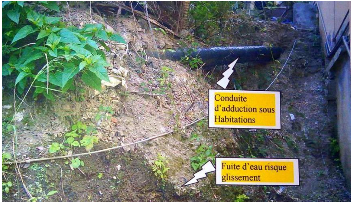
Figure (III.7) : Conduite de refoulement \Phi 200 (SP-SR)
