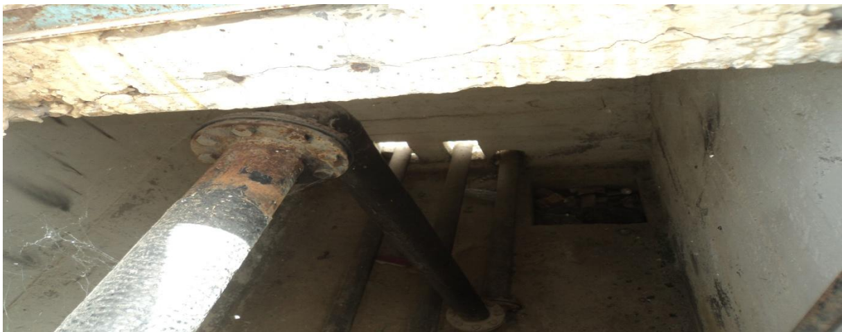
FigureIII.02 : Conduite de vidange du réservoir (état érodé)
