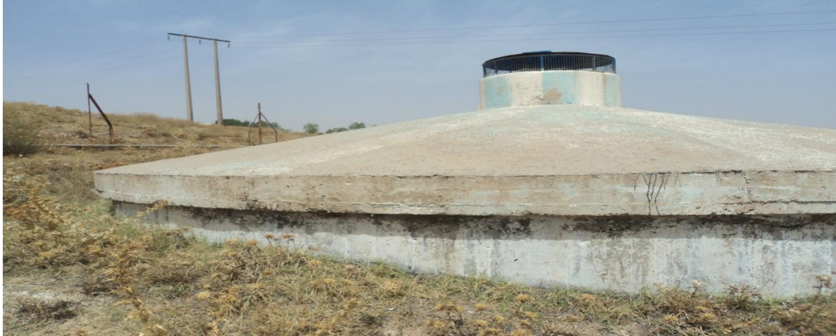
Figure III.01 : Réservoir semi-enterré 150 m3 d'Ouled Adouane
