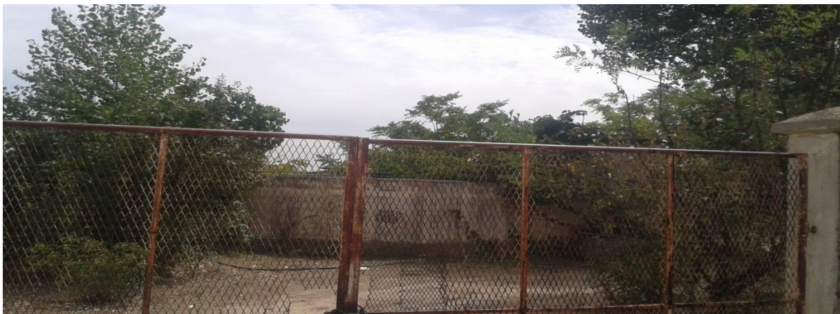
Figure III.06 : Réservoir semi-enterré 250 m 3 d'Oum Laadjoul
