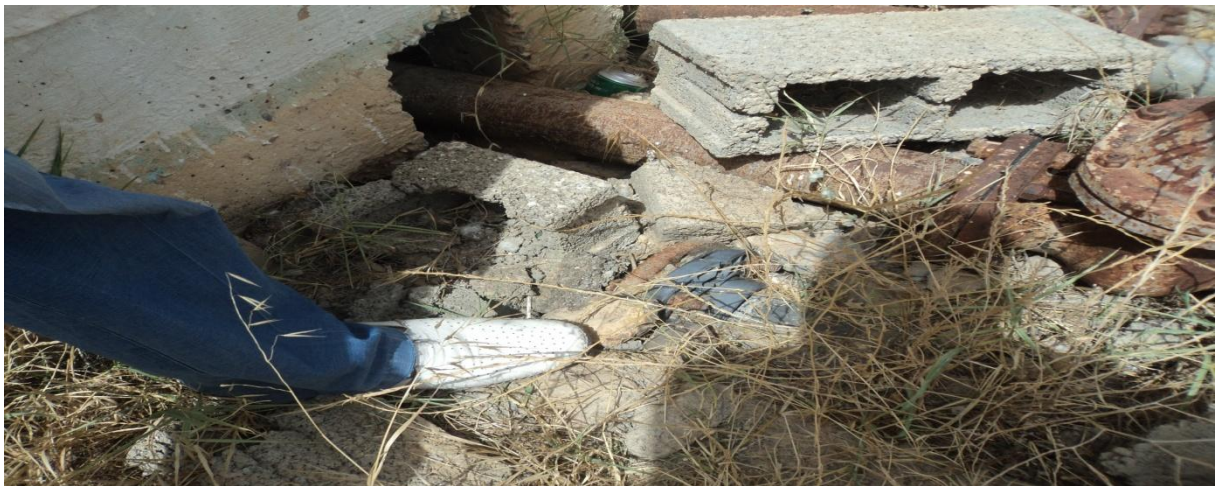
FigureIII.02 : Conduite de vidange du réservoir (état érodé)
