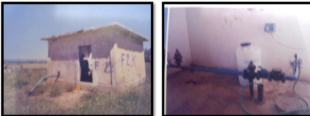
Figure IV.2 : Vue du forage F2 KERFA : Ses équipements et son abri.
