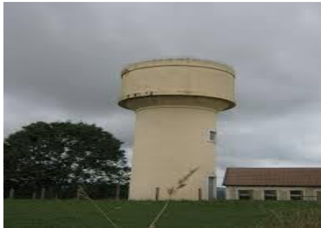
Figure VII.1: ouvrage hydraulique (château d'eau)
