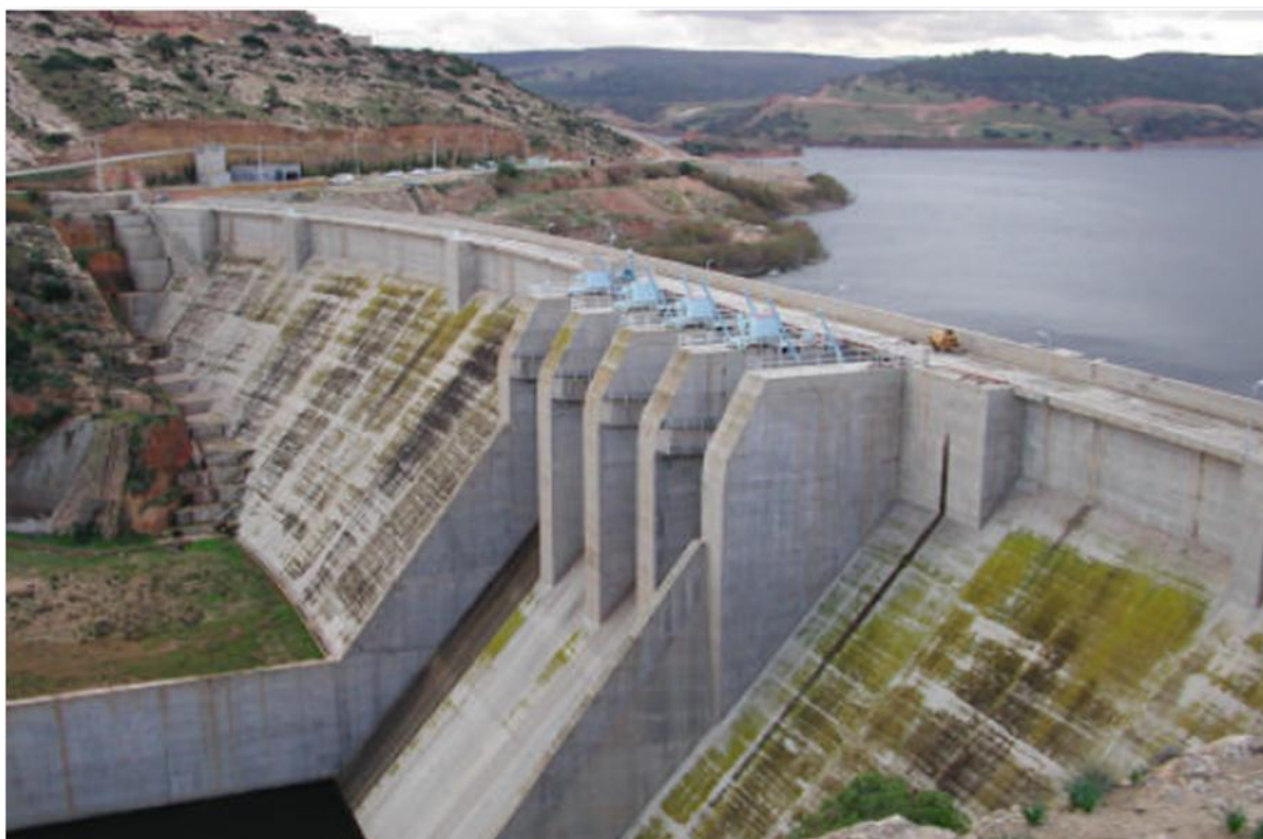
Figure A. II.14 : Barrage de Cheurfas II (ANBT, 2017)
