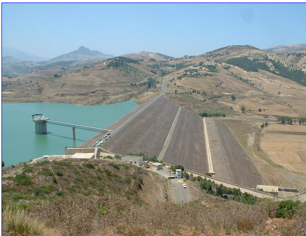
Figure Ann. B.1 Vue rive gauche du Barrage de Boukourdane (ANBT, 2017)
