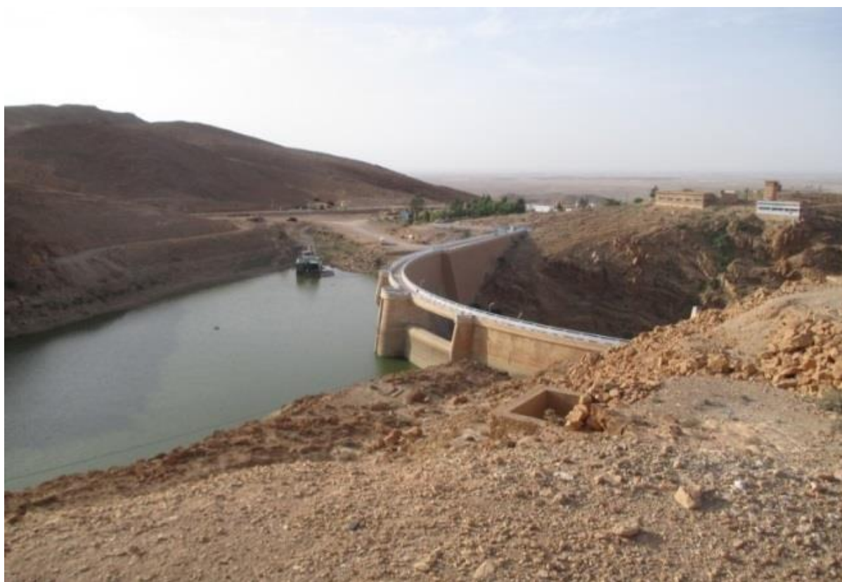
Figure A. II.9 : Barrage de Foug El Gherza (ANBT, 2017)
