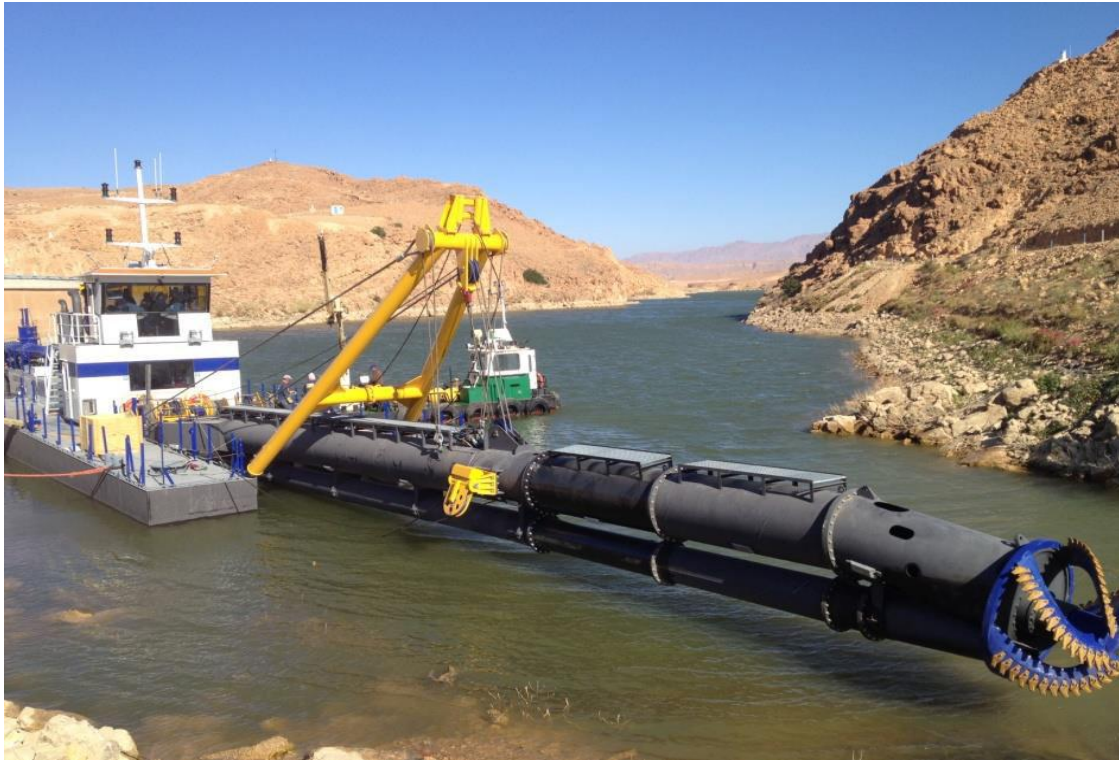
Figure IV. 5 Opération de dragage du barrage de Foum el Gherza (ANBT, 2021)
