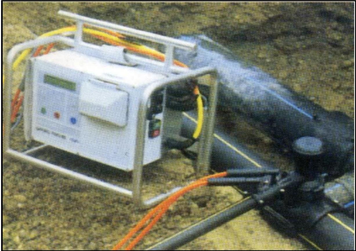
Figure 6.7 : Raccordement par accessoires électro-soudables
