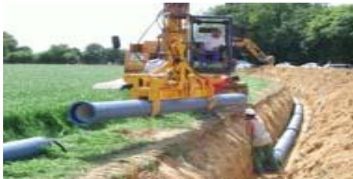
**Figure 8.1:** Pose de conduite dans un terrain ordinaire.
