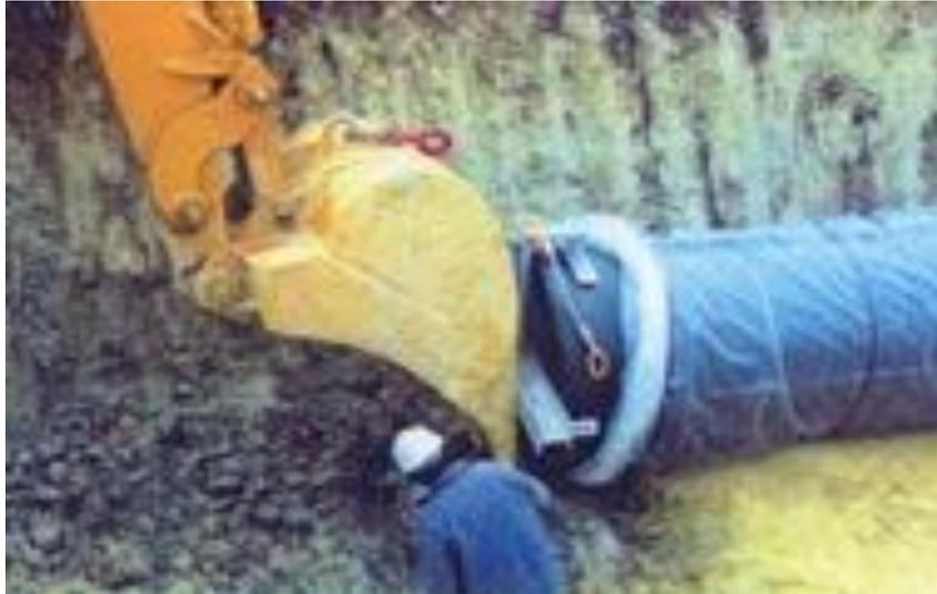
**Figure 8.3:** Pose de conduites dans un terrain agressif.
