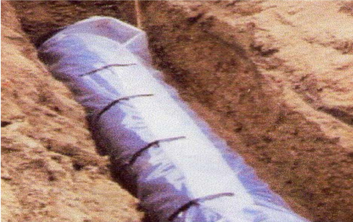
Figure VI.8 : Installations de tuyaux recouverts d'une protection en polyéthylène
