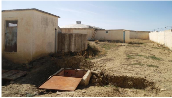
Figure III.5: Réservoir existant (5000m 3 ) en bon état
