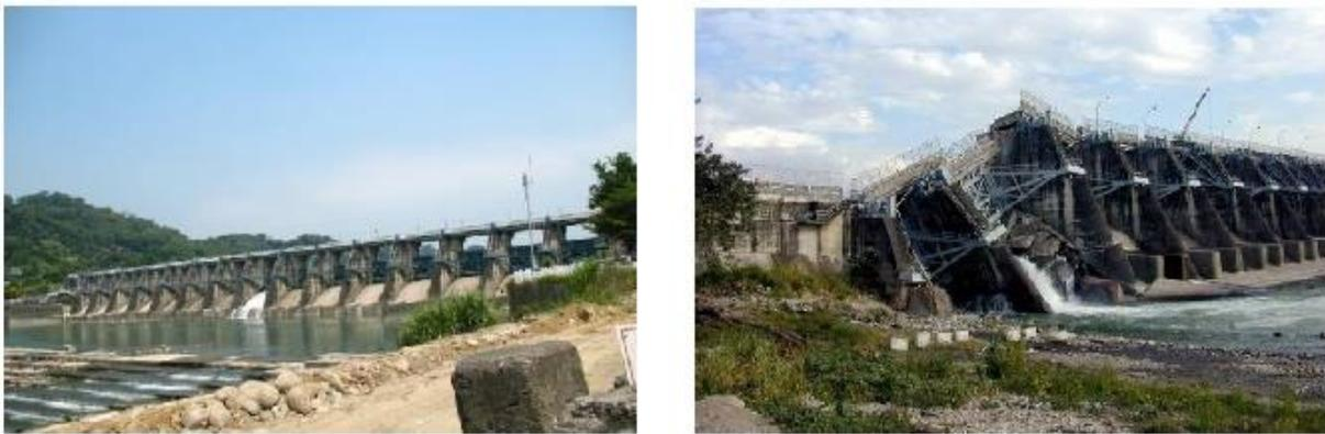
**Figure I.17 :** Le barrage de Shih-Kang avant et après sa rupture
